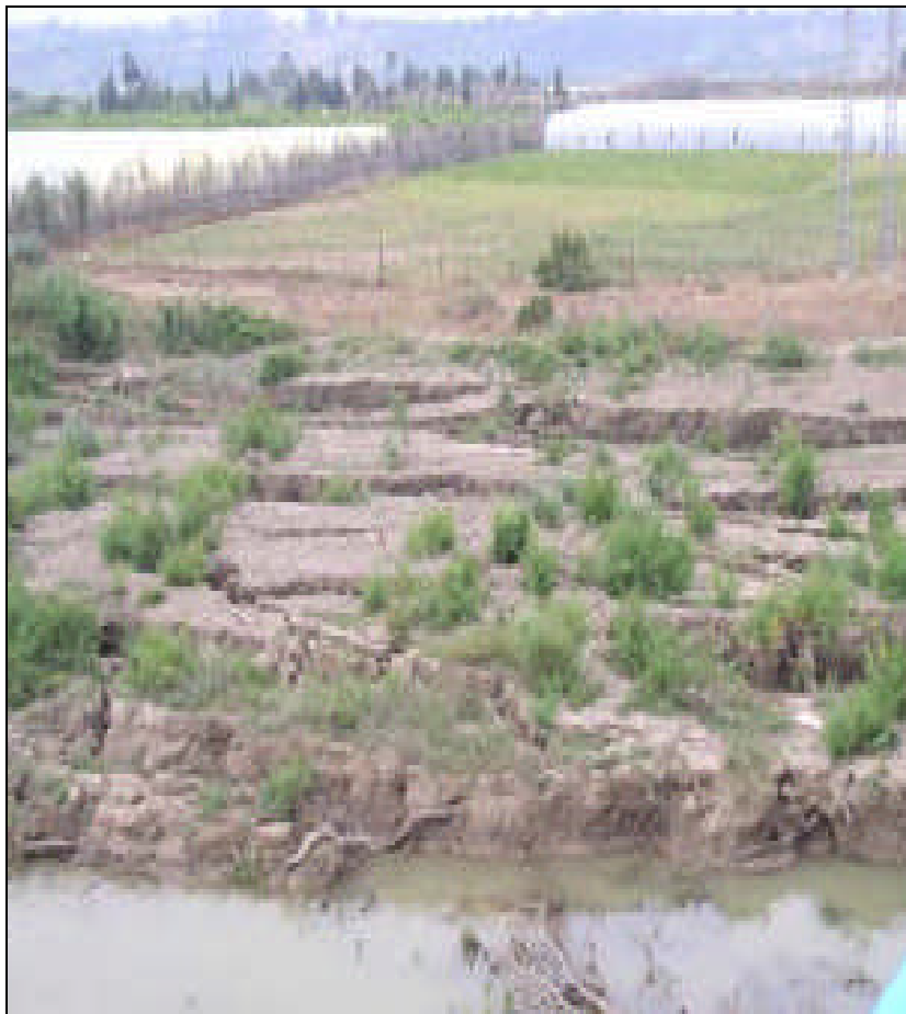
Figure 3.8 Liquéfaction du sol aux abords de l'oued Isser Boumerdes[18]
