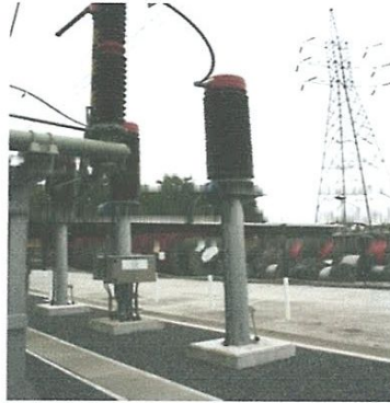
Fig.I.21 : Image d'un transformateur de tension
