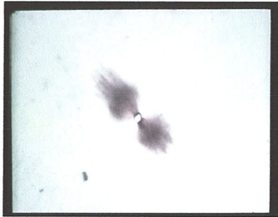
Figure.II.5 : Une décharge partielle a entraîné une arborescence électrique.
