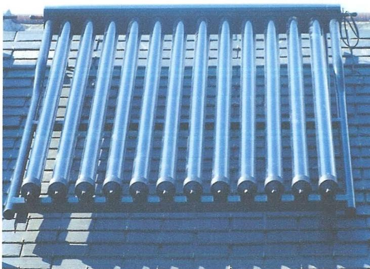
Figure I-9: les tubes thermiques sur un toit de maison
