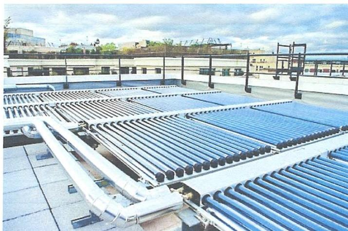
Figure I-8 : l'exploitation de l'énergie solaire par les tubes thermiques
