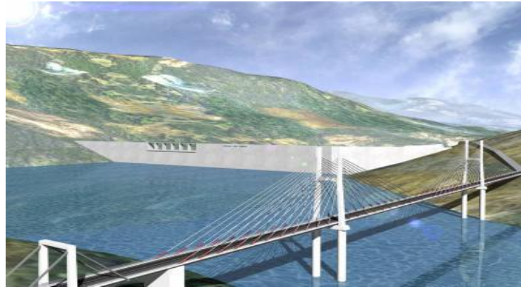
Figure 17 : image en 3D du barrage Beni Haroun
