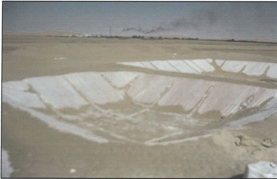
Figure III.1. Bourbier étanche avant le forage
