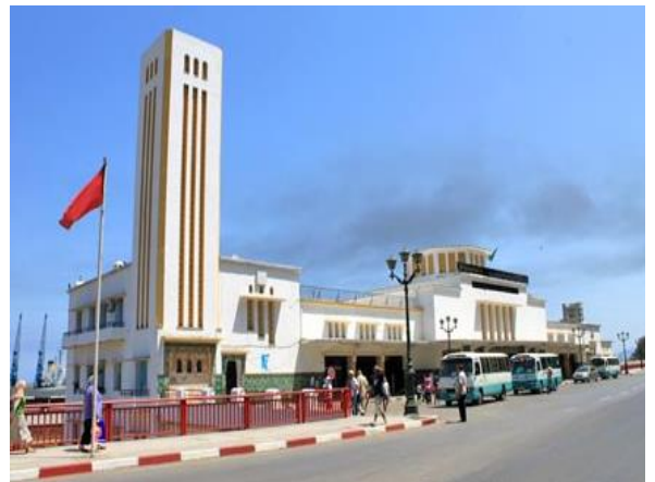
Figure 62 : la gare ferroviaire
