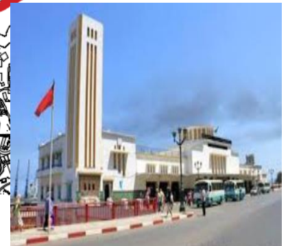
Figure 73 : la gare ferroviaire
