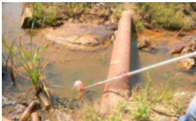
Figure 85 : canal de rejet (1) de la du complexe de transport et de stockage des hydrocarbures(RTE).
