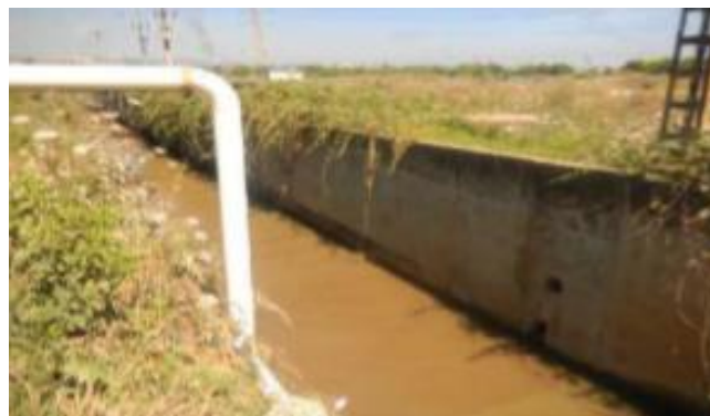
Figure 86 : canal de rejets (2) du complexe de Raffinage du Pétrole (RAF)
