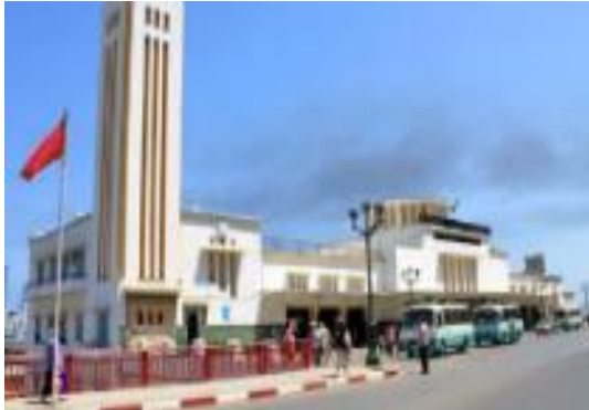
Figure 78 : la gare ferroviaire
