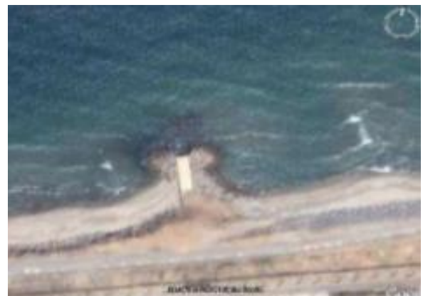
Figure 91 : rejet 3 de la centrale thermique électrique CTE
