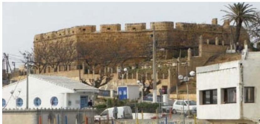
Figure 58 : Les remparts de la ville
