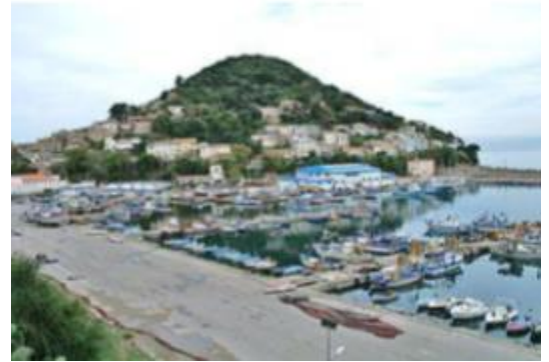
Figure 54 : Le port Collo à Skikda (Source http://www.infrastructure.de.skikda.com )
