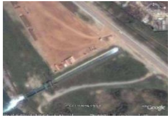
Figure 88 : Rejet 5 du canal de rejet du complexe du gaz naturel liquéfié GNL
