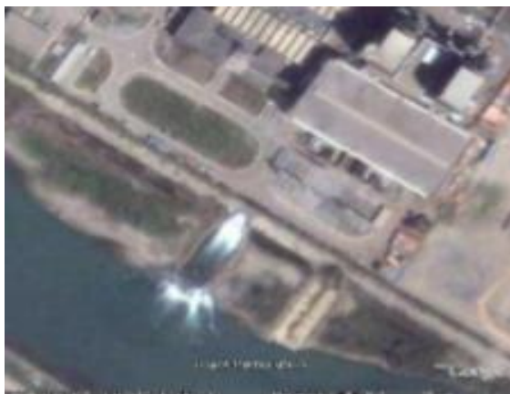
Figure 90 : Rejet 6 du canal de rejet du complexe des matières plastiques (CP1K
