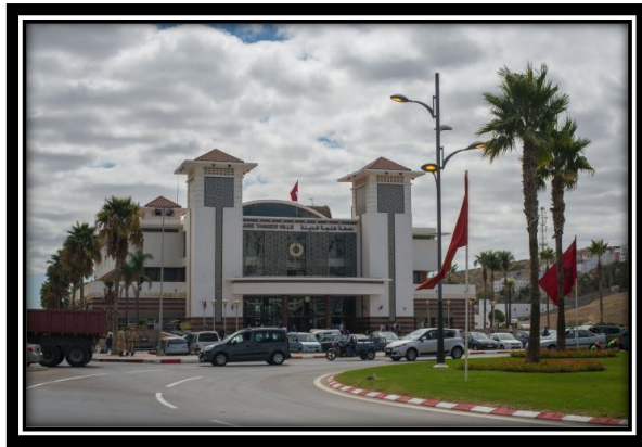
Figure 25: La façade principale de la gare
