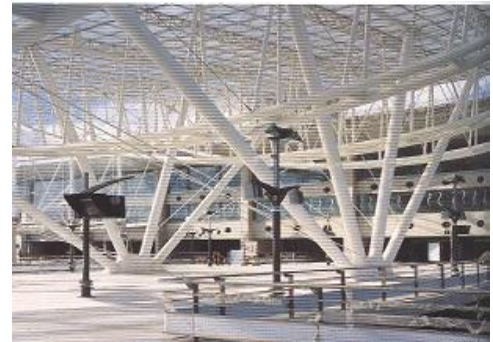
Figure 7: vue sur la structure de Roissy
