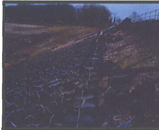
*Figure II.12 : Pneu sol pour protection des pentes et des berges.*
