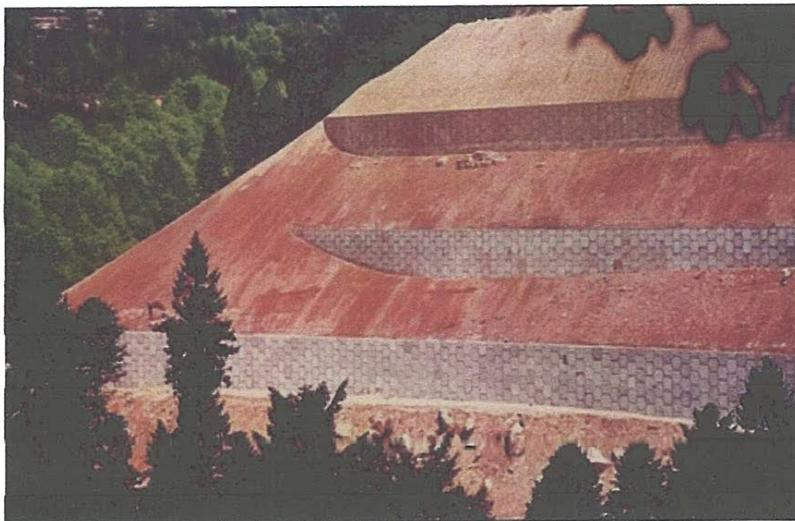
*Figure II.1 : Utilisation de la technique de terre armée*
