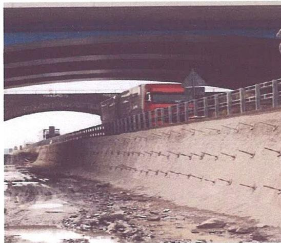
*Figure II.5 : Utilisation de la technique de Clouage*
