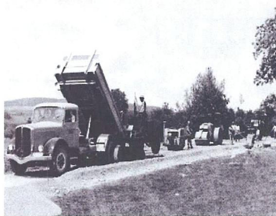
*Figure I.3 : Construction d'un chemin avec matériaux stabilisé Selon le procédé mix in plant.*
