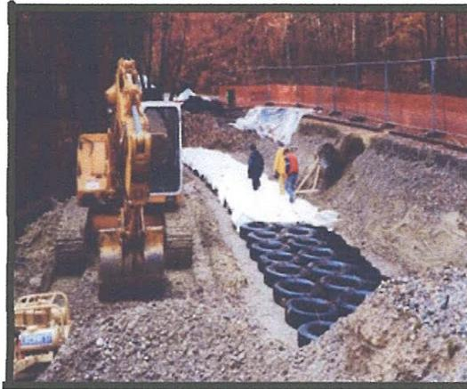
*Figure II.11 : Remblai léger en crête de talus.*
