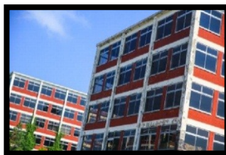
Figure 15 : L'ancienne usine de chaussures Bata
