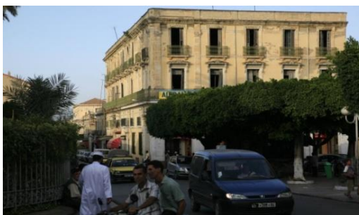
Figure 40 : L'état des constructions de l'époque coloniale
