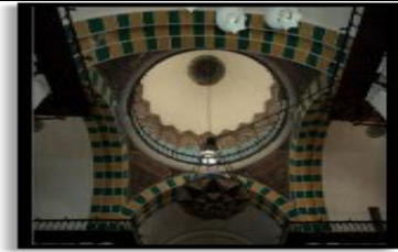
Figure n° 55: Coupole ovoïde Djamaa Djadid à Alger
