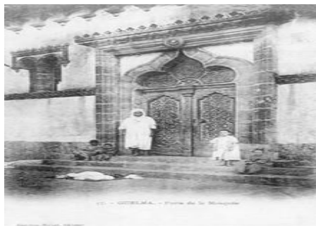
Figure n° 101: La porte de la mosquée EL ATIK
