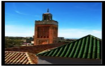
Figure n° 40: Couverte en tuiles de la grande mosquée de Tlemcen
