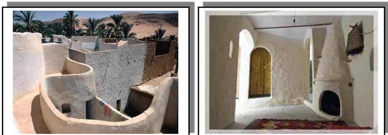
**La maison mozabite** correspond au type de maison à patio souvent central, il n'est pas rare qu'il s'appuie contre l'un des quatre murs, Percée à l'extérieur seulement par la porte d'entrée, toujours composition en façade, sur les murs des chicanes tels des yeux, permettant l'exercice du droit de curiosité des femmes.
