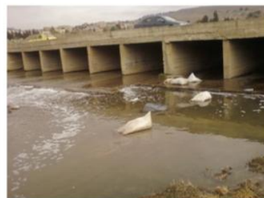
Des sacs de ciment Boumerzoug (Sissaoui)
