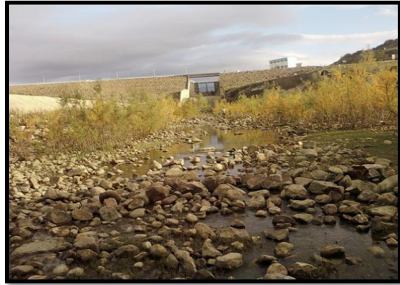
Photo 3 : Barrage de la Mexa
