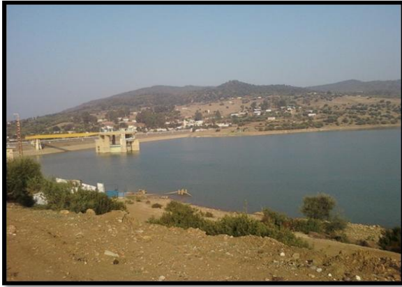
Photo 2 : Barrage de Cheffia
