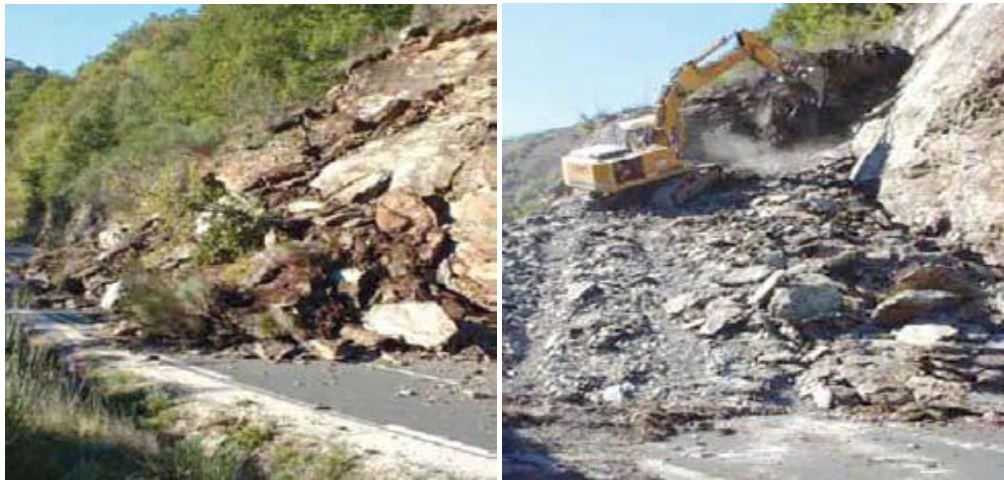
Fig. III.39 Purge d'un éboulement sur voie de circulation. [12]
