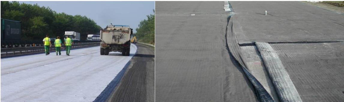
*Figure 43: Mise en place des géosynthétiques dans une construction de route*
