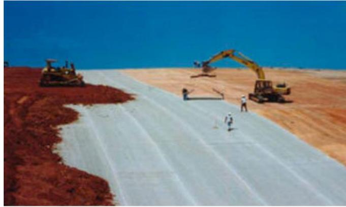
Figure 44: Renforcement de sol à l'aide géotextile
