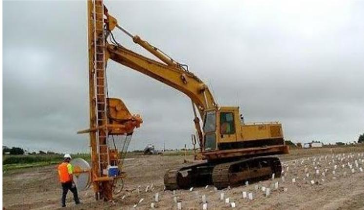
Figure 49: Technique de drains verticaux
