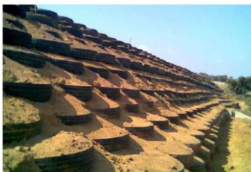
Figure I.5. Chantier expérimental Pneusol à Bou-Smail[19]
