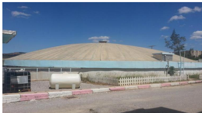
Figure II. 7. Réservoir de stockage.
