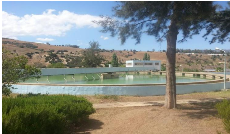
Figure II. 5. Bassin de décantation.
