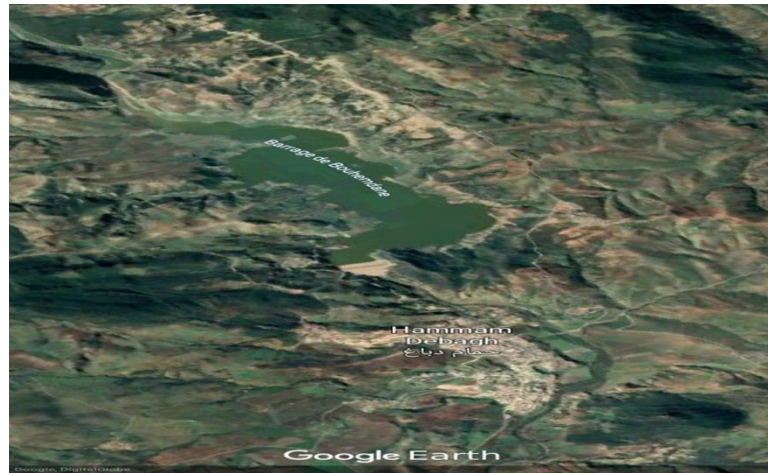
Figure IV. 1. Photo satellitaire du barrage Hammam Debagh (Google Earth).
