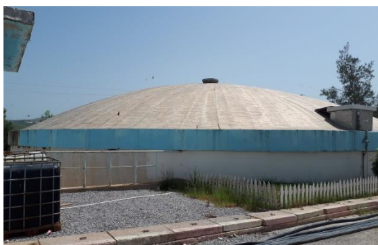
Photo 3 : Réservoir de stockage.
