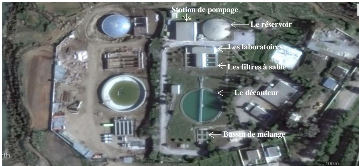
Figure III.2 : Présentation de la station de traitement des eaux Hammam Debagh [34].
