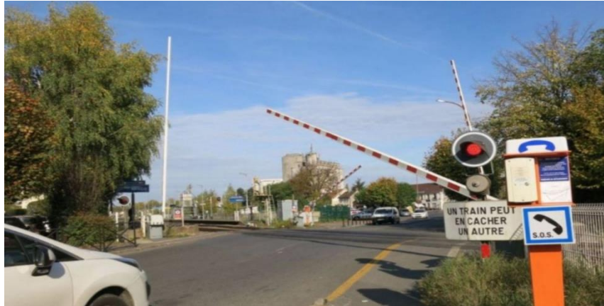
Figure 1.11 : Passage à niveau : Franchissement d'une voie ferrée [11].
