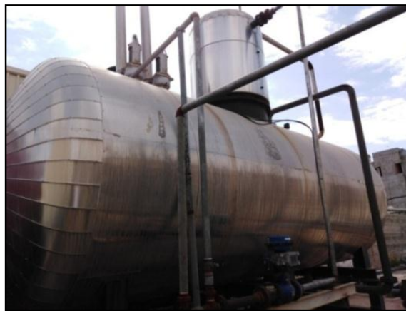
Figure 17 : Dégazeur (photo prise par NOUADRI, 2019).
