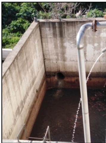
Figure 18 : Décharge de l'eau usée dans la station d'épuration (photo prise par NOUADRI, 2019).
