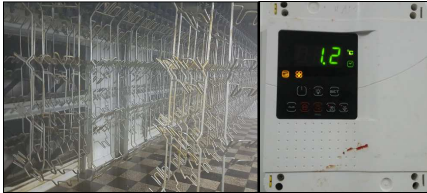
Figure 26: Image de la chambre de ressuage [Source : photos personnelle]
