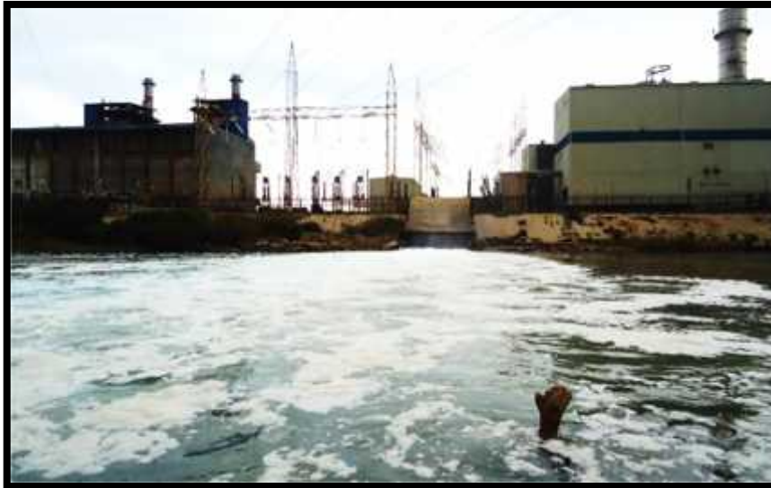
Figure 15 : Canal de rejet de complexe de gaz naturel liquéfié (GL1/K) (pp, 2019).
