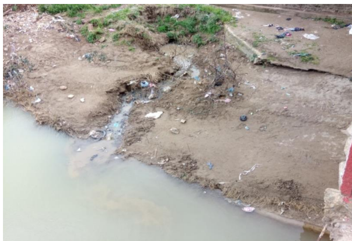
Photo 06 : Les eaux usées (prise personnel).
