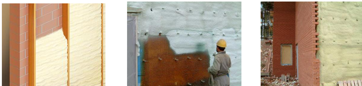
Figure I.6 Méthodes d'application de mousse pour l'isolation murale.
