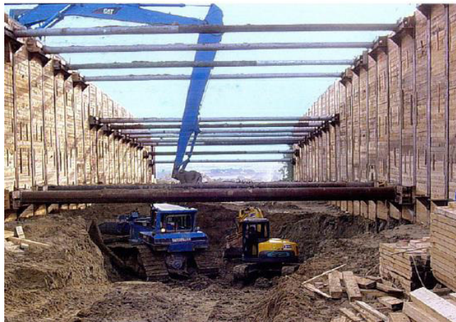
Figure. I.15 Paroi berlinoise butonnée [25]
