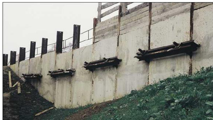
Figure. I.8 Paroi berlinoise ancrée par des tirants précontraints [23]
