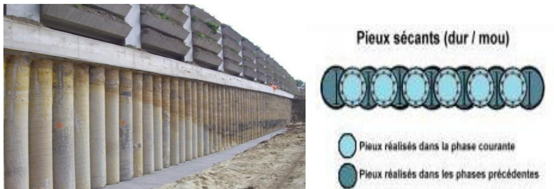
Figure. I.13 Paroi de pieux sécants [42]
