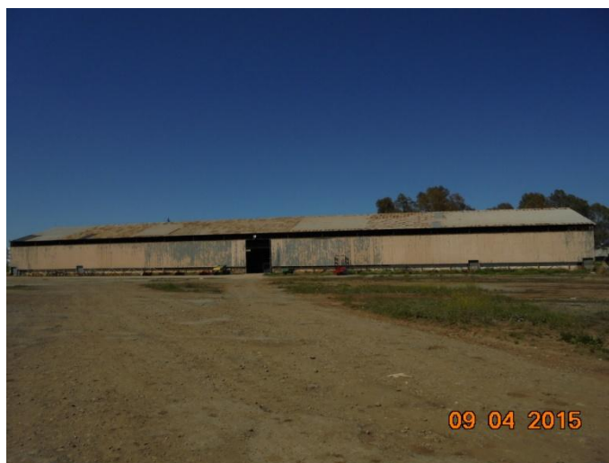
Figure 12 : Photo de l'hangar d'entretien
