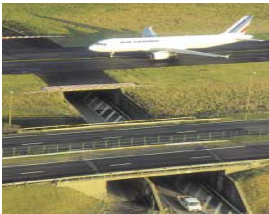
Figure 24 : Aéroport de Paris-CDG. Pont de voie de relation
