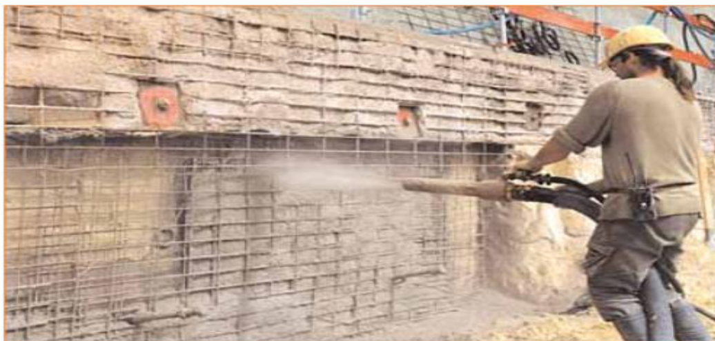
Figure II.13. Réalisation du parement par béton projeté
