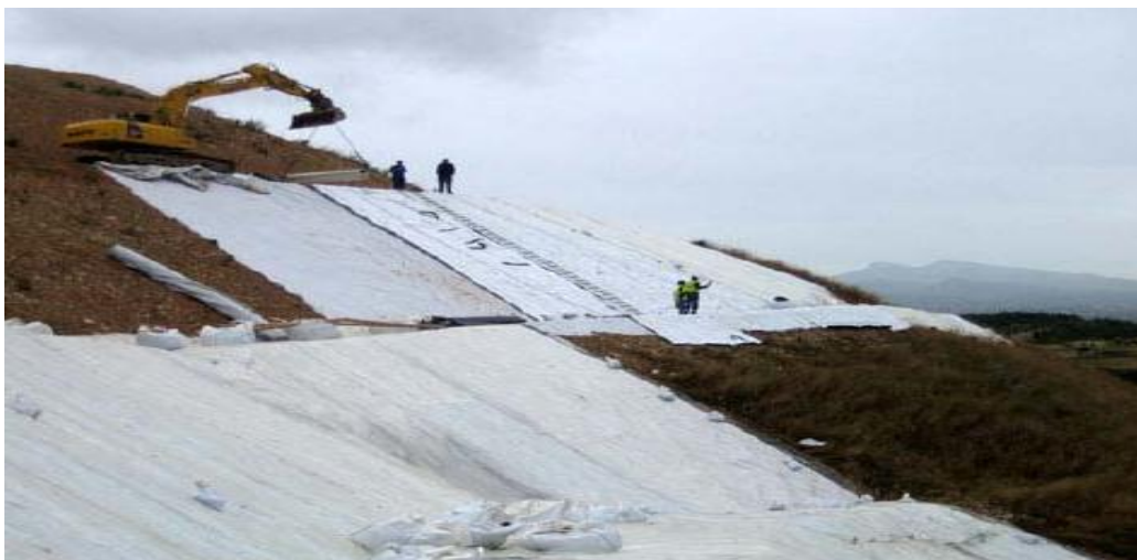
Figure III.6. Mise en place de la géogridde de retenue des terres.
