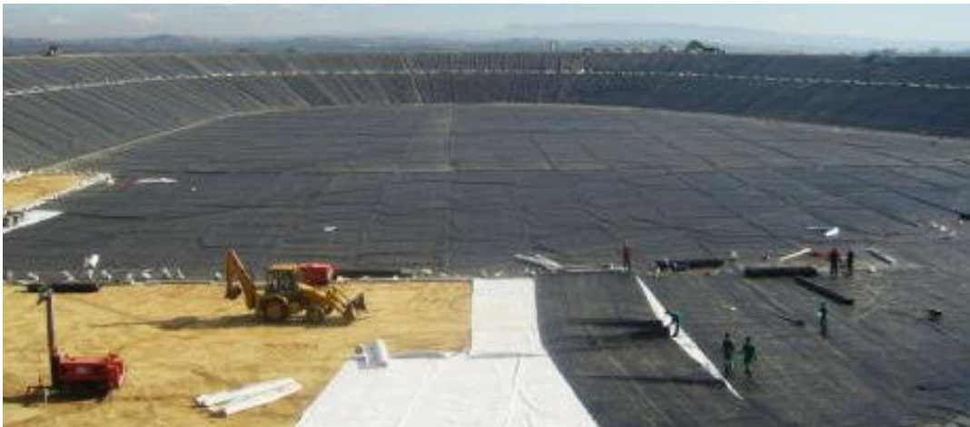
Figure III.2. Mise des géogrilles au-dessous des drains.
