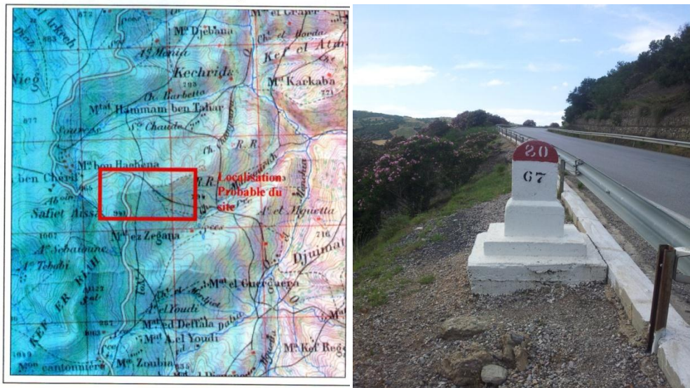
Figure V.1. Localisation du point de glissement sur la RN80 Pk67+500
