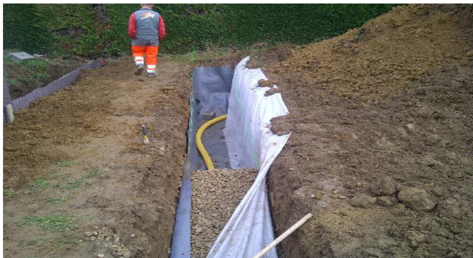
Figure V.31. Détail de réalisation d'une tranchée drainante
