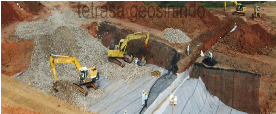
Figure III.3. Séparation de matériaux de remblais
