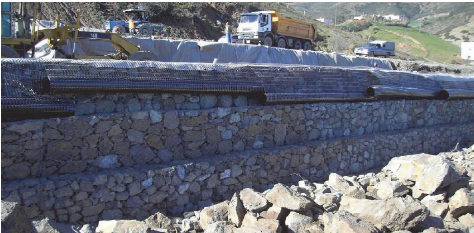
Figure III.5. Mur de Protection contre le glissement
