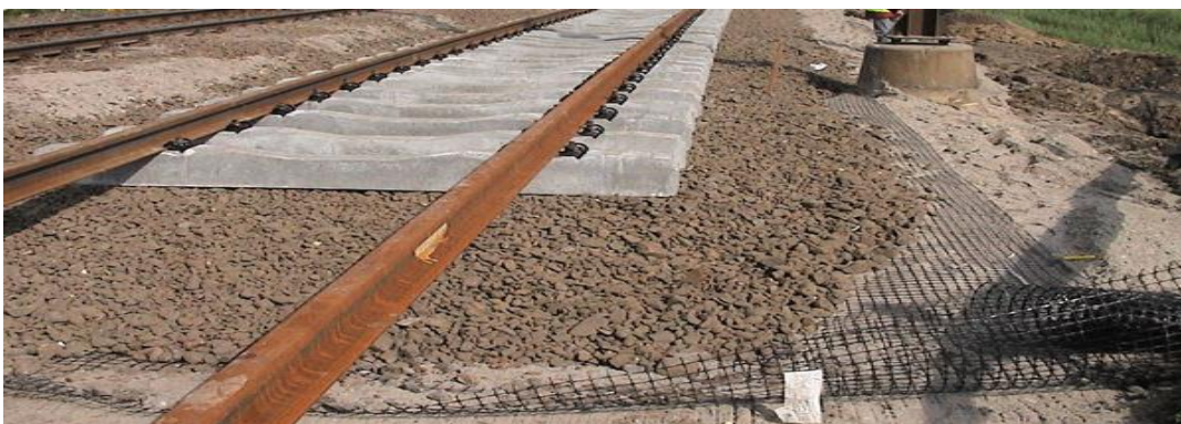
Figure III.1. Installation des géogrilles au niveau des traverses, avant le levage et le bourrage du ballast
