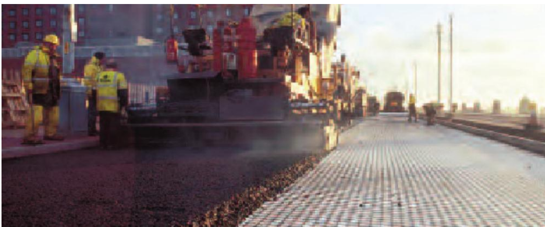
Figure III.4. L'enrobé est mis en œuvre directement sur la géogridle
