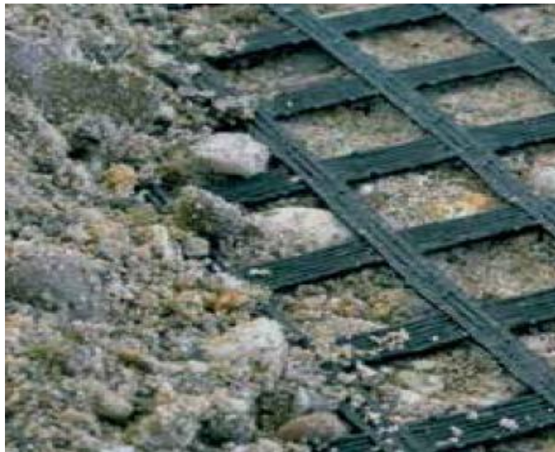
Figure III.11. Matériau de remblai
