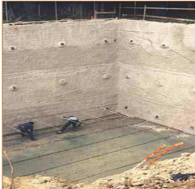
Figure II.10. Ouvrage neuf, paroi clouée en soutènement d'excavation.
