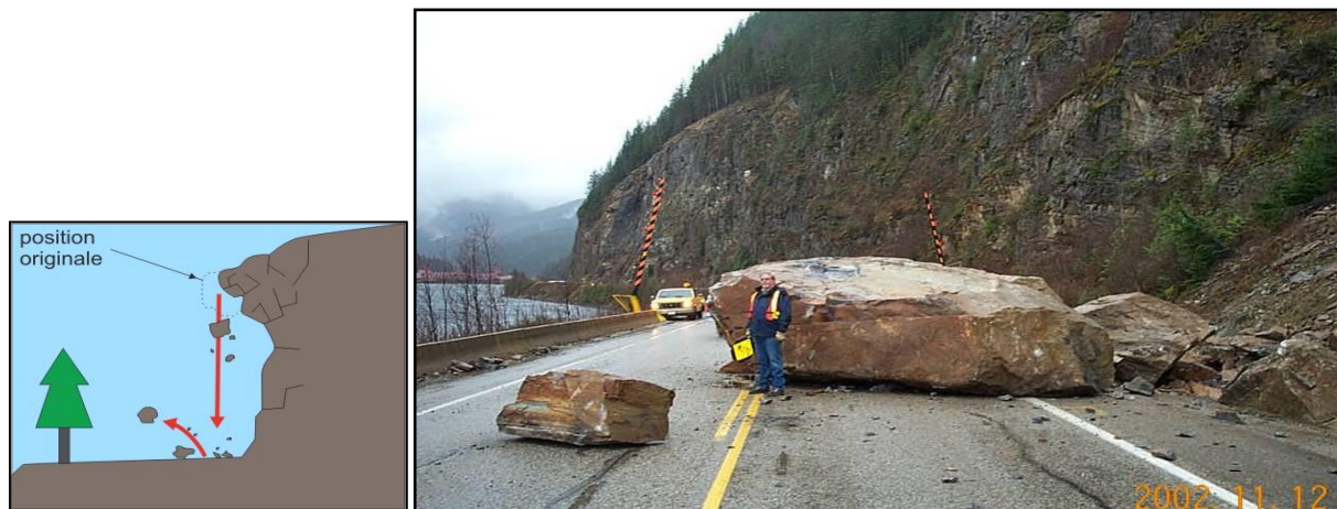
Figure I.1. Eboulement ou chute de pierre [4]
