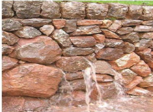
*Figure I.2. Le drainage des murs secs*
