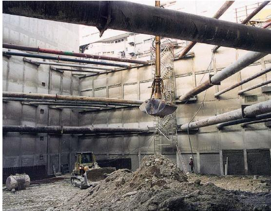
*Figure I.9. renforcement par butons*
