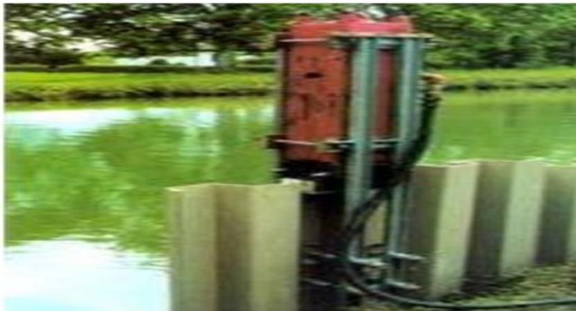
*Figure I.12. Mise en place de palplanche Pvc*
