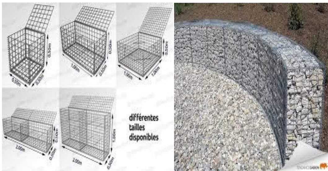
*Figure I.3. Mur en gabion*
