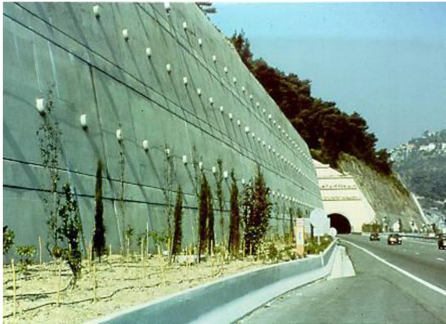
*Figure I.13. Exemple de mur cloué*
