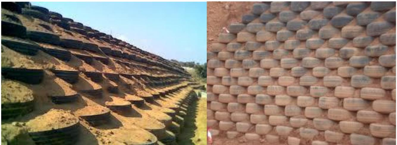
**Figure I.15. Mur en pneu sol**
