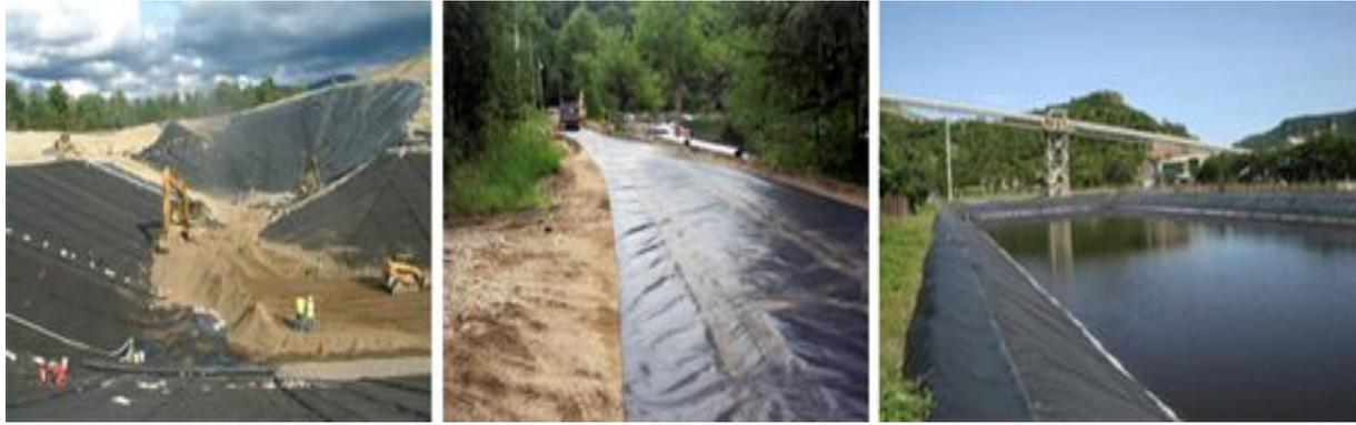
*Figure I.19. Exemple de géomembrane*
