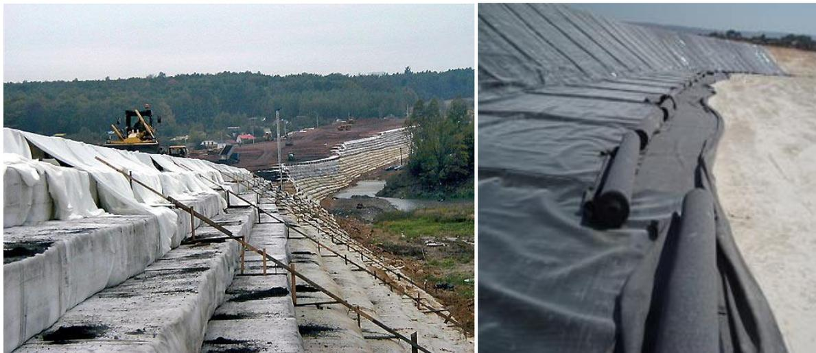
*Figure I.16. Exemple de géotextile*
