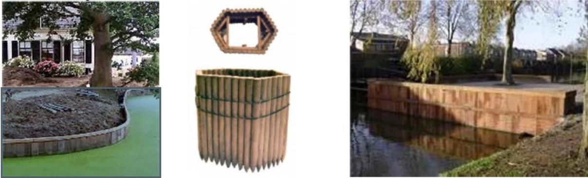
*Figure I.11. Exemples de réalisation en palplanche bois/ protection de berge à gauche et droite et batardeau au centre*
