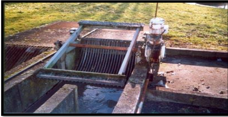
Figure 3 : Schéma d'un dégrilleur
