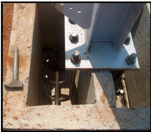
Figure X.4 : Tige d'ancrage
