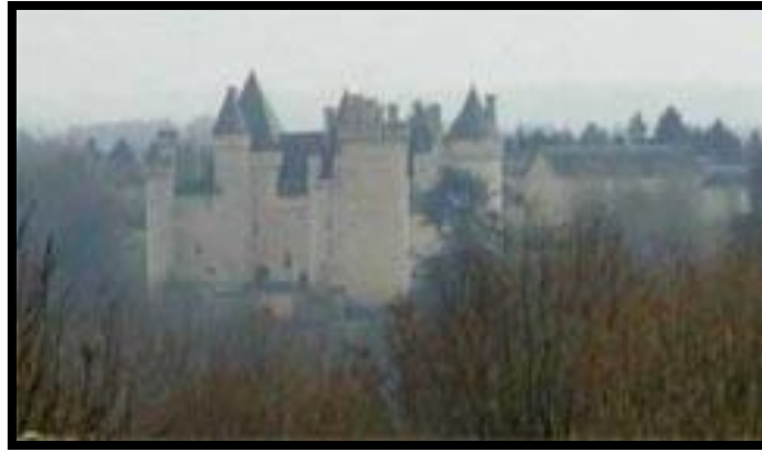
Photo 1. réhabilitation d'une construction ancienne
