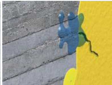
imperméabilisation des membranes endommagées
