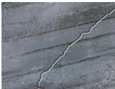
Réparation des fissures et cavités structurelles
