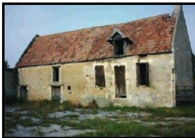
photo 2. une construction ancienne avant la rénovation
