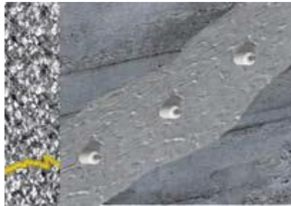
Figure IV.6 : Réparation des fissures et cavités structurelles
