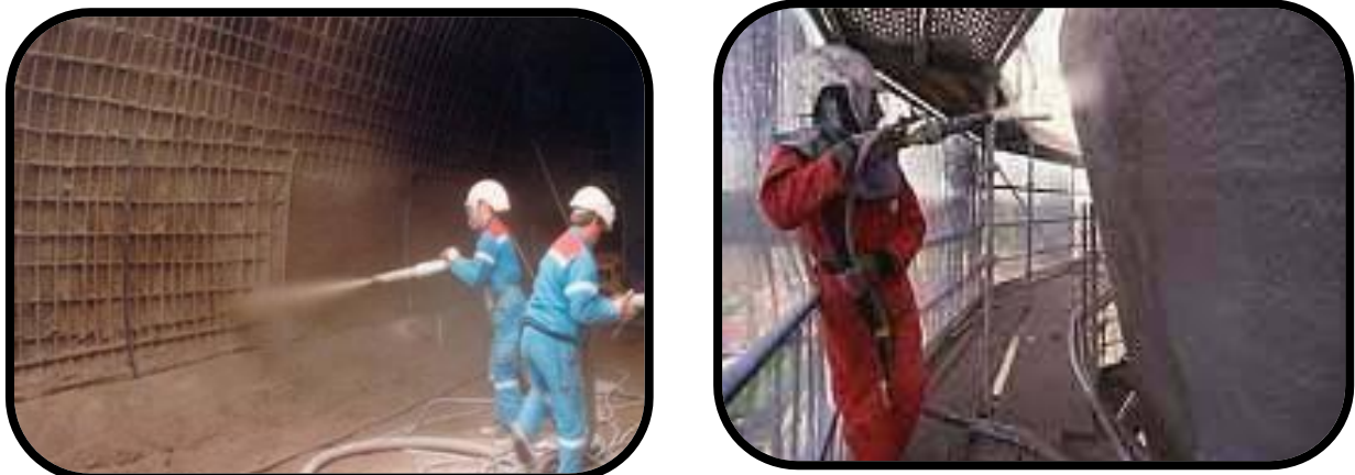
Figure IV.1 : Renforcement au moyen de béton projeté.
