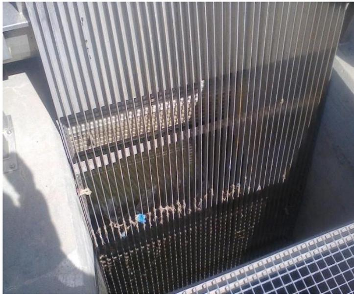
**Figure III-3 : Un dégrilleur**
