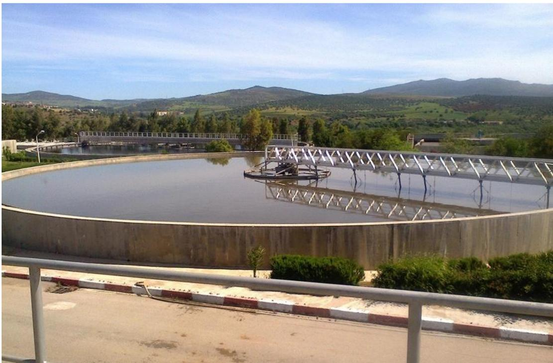
**Figure III-5 : Décanteur primaire**
