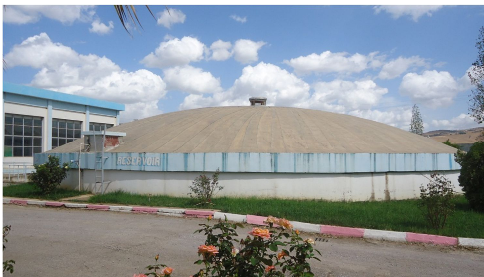
Photo. 8 : Réservoir de stockage
