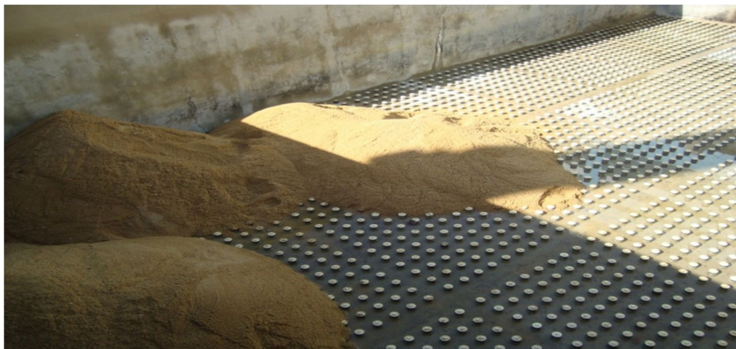
Photo. 7: Dalle de béton avec les buselures des filtres
