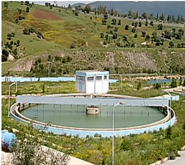
Photo. 5 : décanteur circulaire statique
