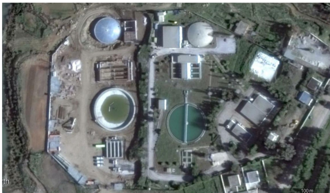
Photo. 1 : Vue aérienne de La station de traitement de l'eau potable de Hammam Debagh wilaya de Guelma (photo Google Earth)
