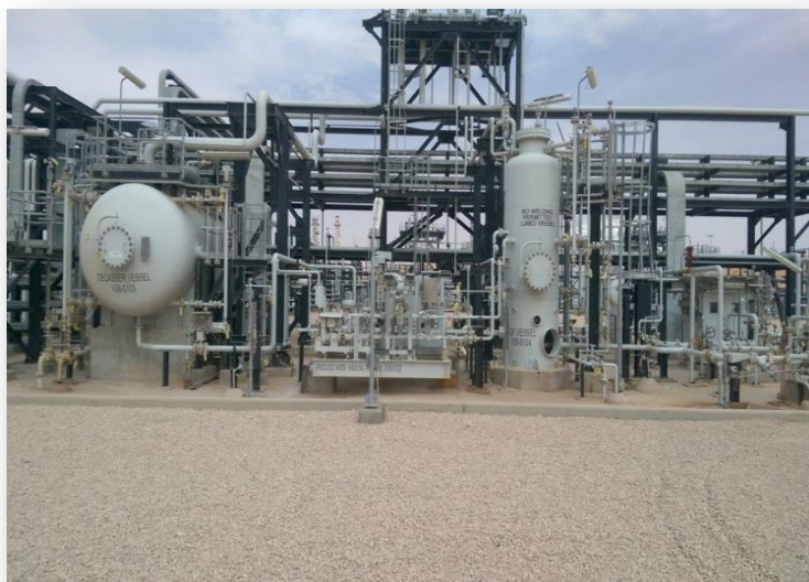
Figure.VI.16 : L'unité de traitement d'eau produite du RKF/STR.
