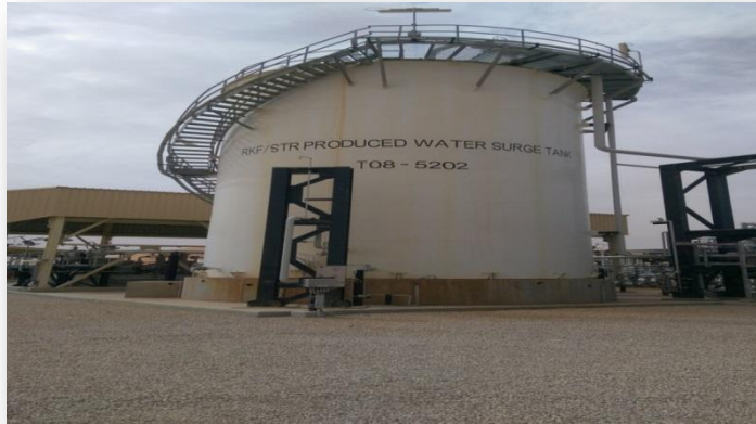
Figure.VI.22 : Le réservoir d'eau produit RKF/STR (T08-5202).
