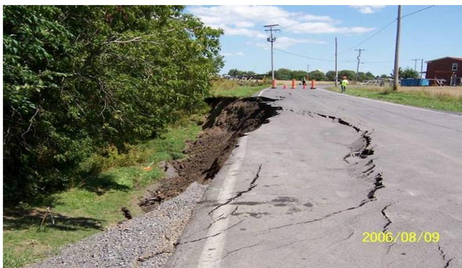
**Figure I.27** : Affaissement de terrain.
