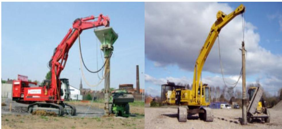
**Figure II.8 :** Les colonnes ballastées
