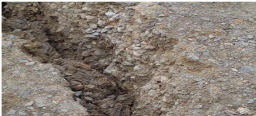
**Photo 2** : Fissure de traction mettant en évidence le corps de remblais.
