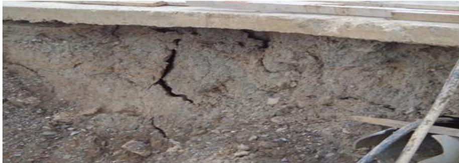
**Photo 4** : Présence d'un escarpement en tête du versant circonscrivant le plan de rupture
