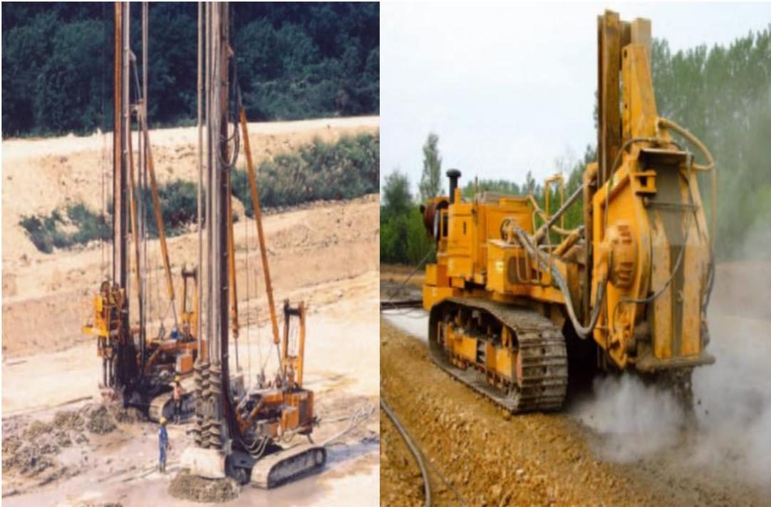
**Figure II.6** : Soil mixing et trenchmix
