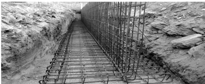
**Figure IV.2** : Ferrailage d'un mur de soutènement.
