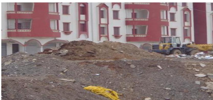
**Photo 7** : Des débris de nature différente, déposés anarchiquement sur le talus
