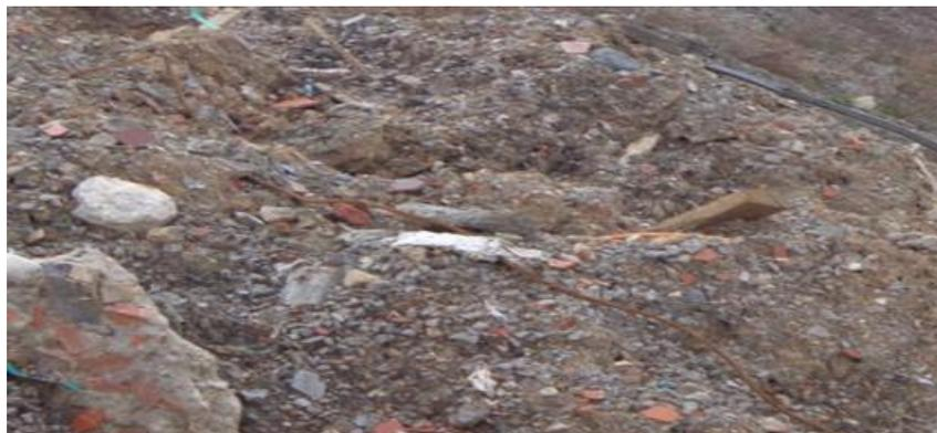
**Photo 6** : Des débris de nature différente, déposés anarchiquement sur le talus
