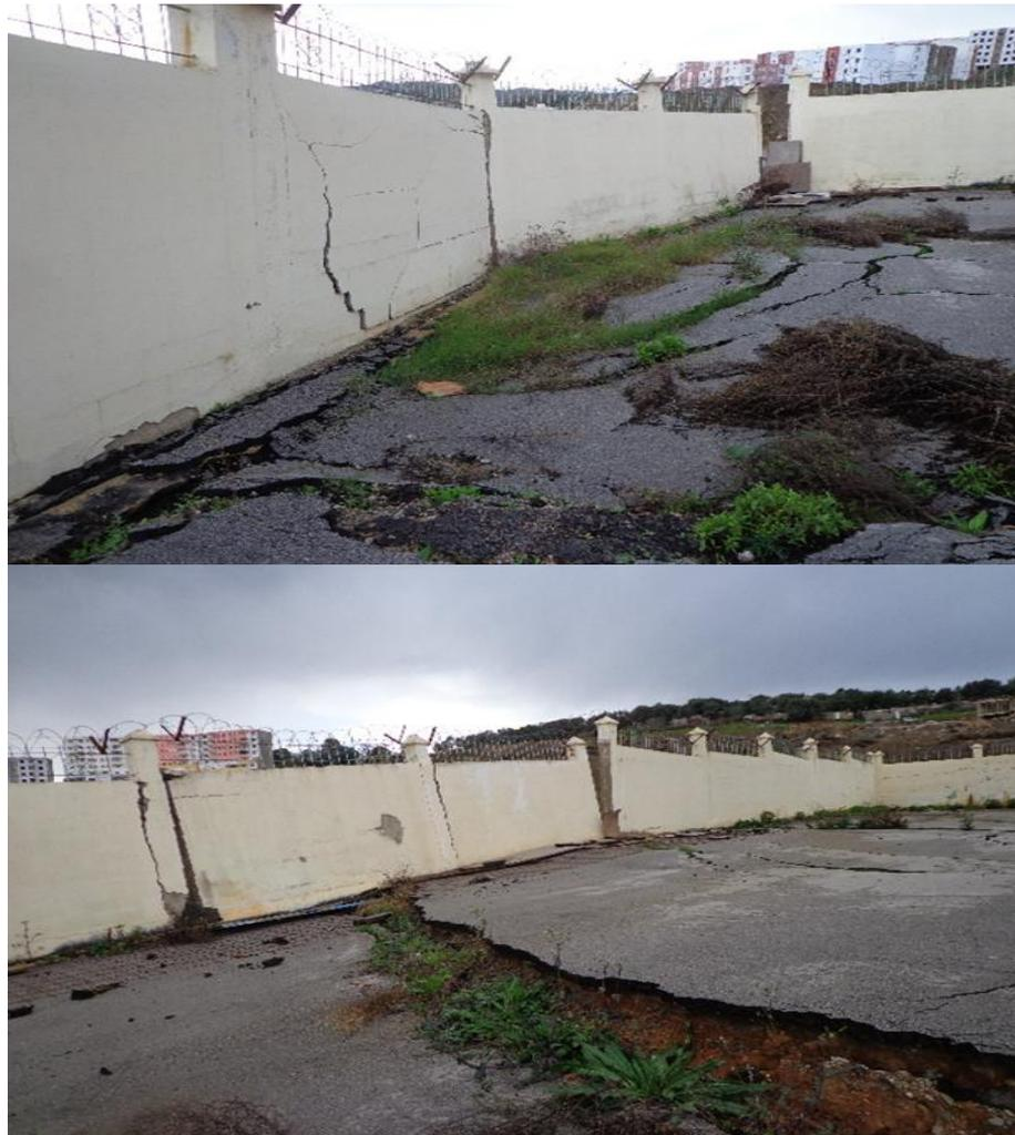
**Figure I.32** : Apparition des fissures, affaissement et la dégradation progressive au niveau de la chape bitumineuse
