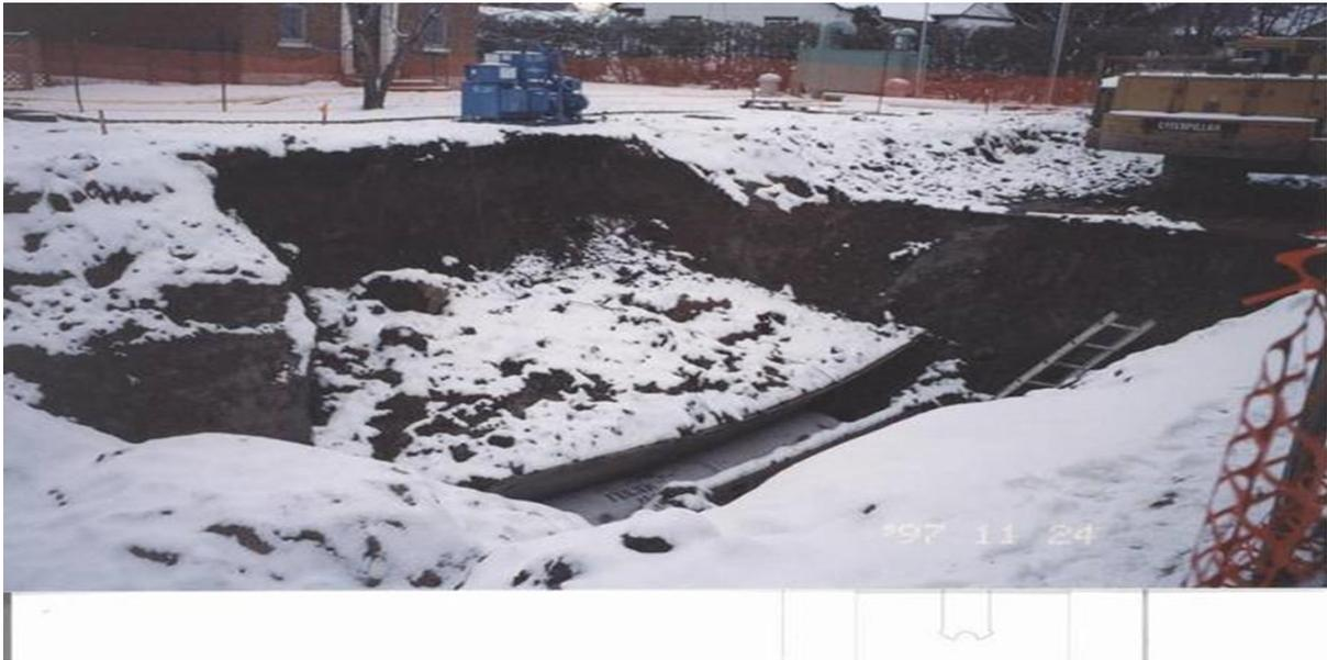
**Figure I.28** : Affaissement du à l'instabilité de l'excavation.
