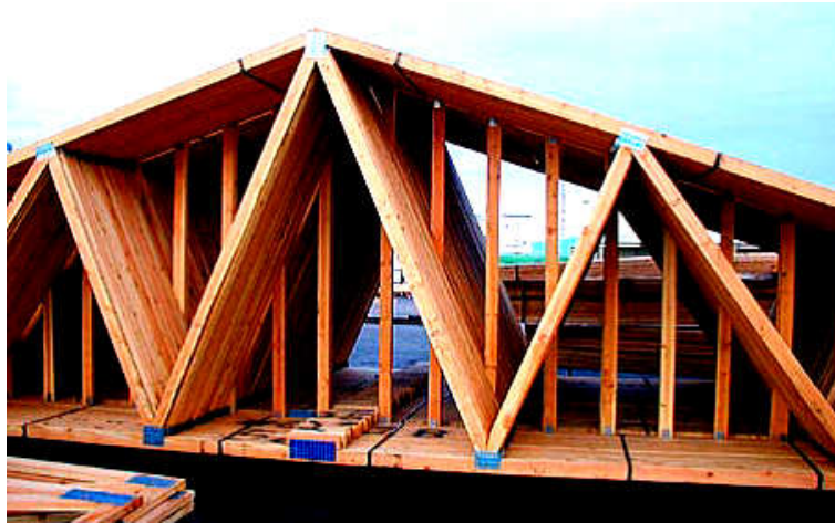
Figure 1.13 : Fermes de toit à connecteurs métalliques (WTCA 2005).
