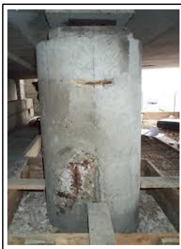
Photo III.1.5 : Pile de pont
