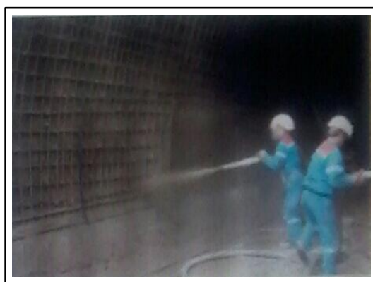
Photo III.4.7 : Projection de béton
