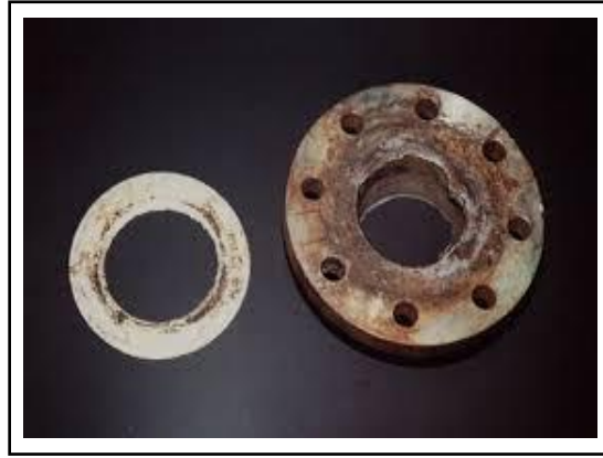
Figure I.7: Corrosion par crevasses
