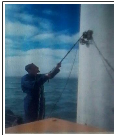
Photo III.2.1 : Détection des armatures au radar
