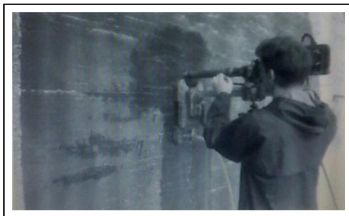
Photo III.2.5 : Prélèvements par carottage
