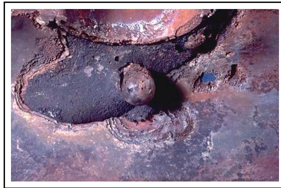
Figure I.9 : Corrosion galvanique
