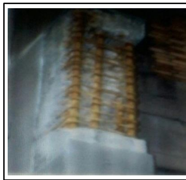
Photo III.4.1 : Protection des armatures [66]
