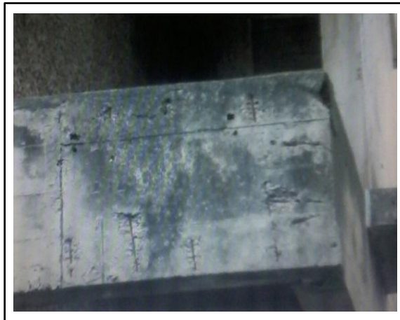
Photo III.1.11 : Parement en béton armé dans un monastère classé
