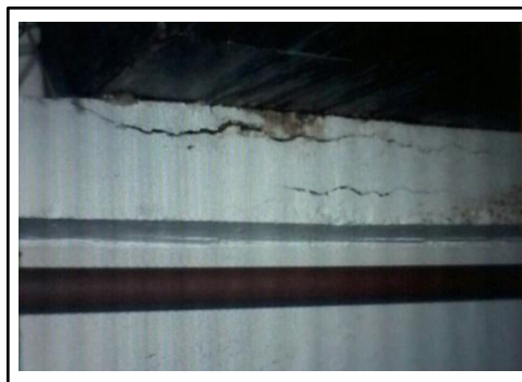
Photo III.1.2 : Poutre support de réservoir
