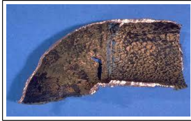
Figure I.8 : Corrosion par érosion
