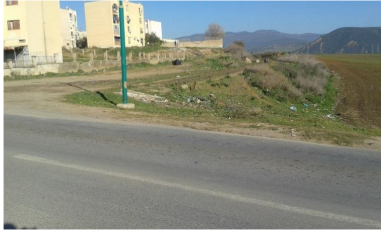
Figure 35 : La ligne enterrée par la RN 20 à la sortie de Boumahra
