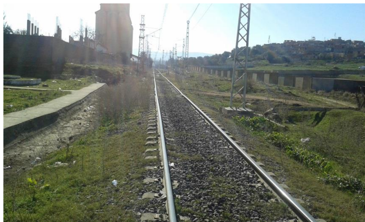
Figure 40 : La sortie de la gare de Bouchegouf en direction de Annaba
