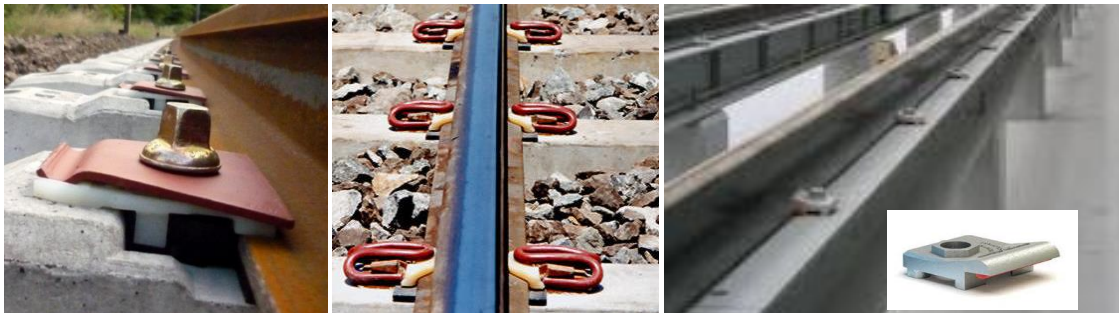
Figure 17 : Attaches Nabla, Pandrol et crapaud élastique
