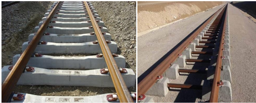
Figure 16 : Traverses en béton monobloc et mixte bibloc
