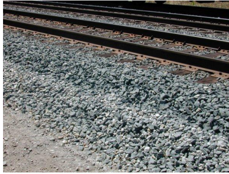
Figure 18 : Photos d'un ballast
