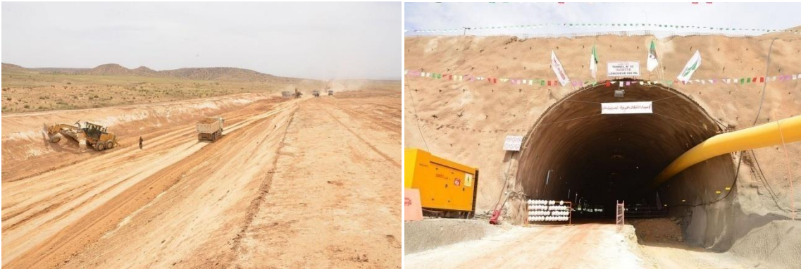
Figure 11 : Photos des travaux de la ligne Boughezoul - Djelfa
