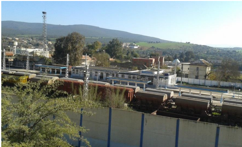
Figure 39 : La gare de Bouchegouf
