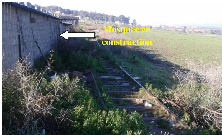
Figure 33 : La ligne à côté d'une mosquée en construction
