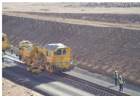
Figure 10 : Photo des travaux en cours
