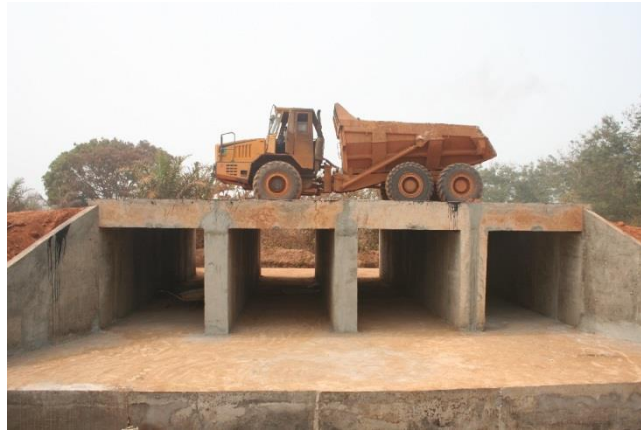
Figure 59 : Image d'un dalot sur un projet en cours de réalisation
