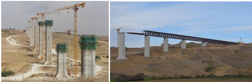
Figure 8 : Photos du viaduc exceptionnel
