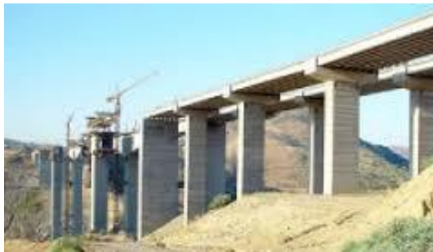
Figure 61 : Image d'un pont en caisson
