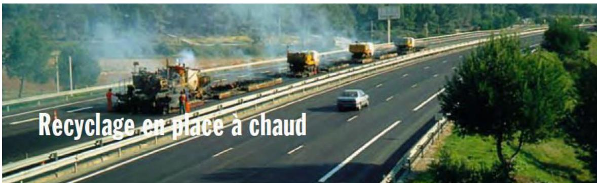
Figure 4.6. Recyclage en place à chaud.
