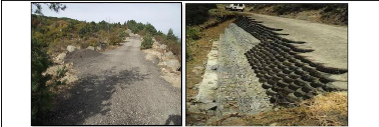
Figure 4.8. Exemple de l'utilisation de fraisât brut (piste montagneuse, renforcement des remblais des routes).
