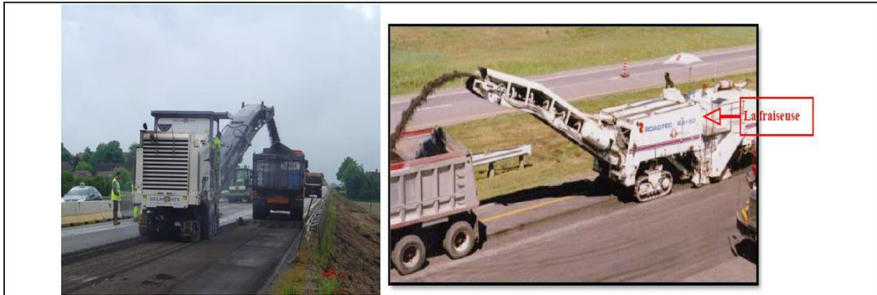
Figure 4.1. L'opération de fraisage.
