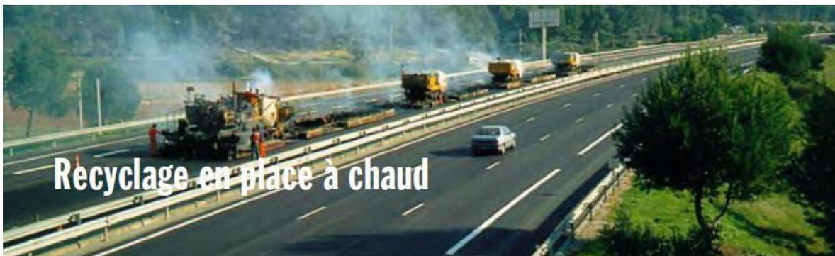
Figure 4.6. Recyclage en place à chaud.
