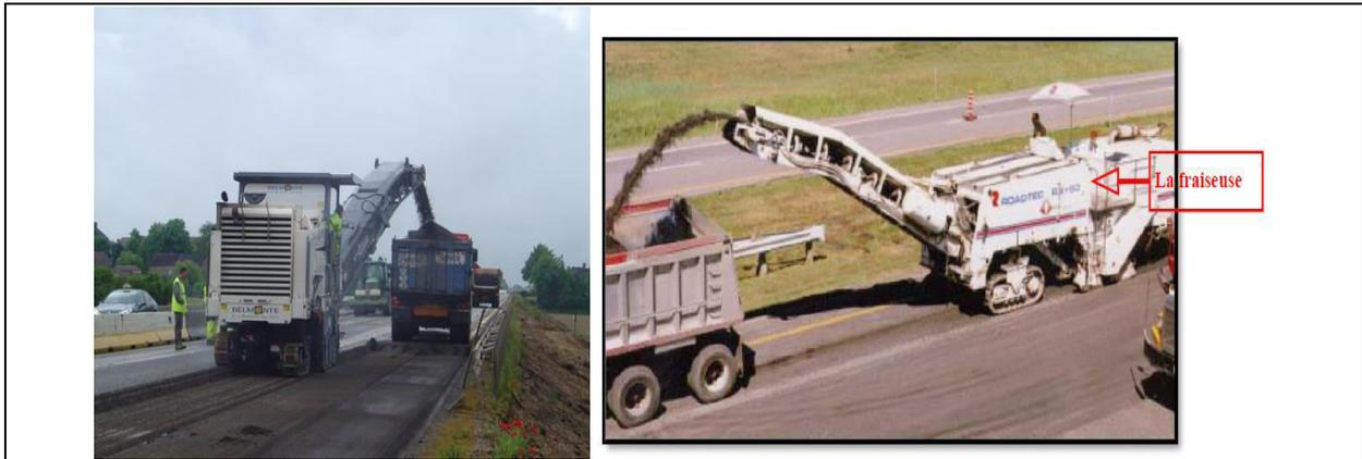
Figure 4.1. L'opération de fraisage.
