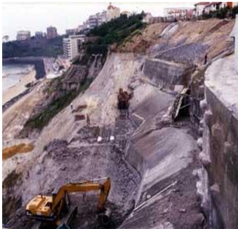
Figure 1.15. Les travaux de terrassements
