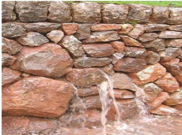
Figure 2.2. Le drainage des murs secs.
