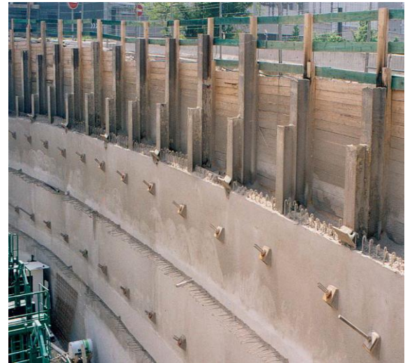
Figure 2.10. renforcement par tirants.
