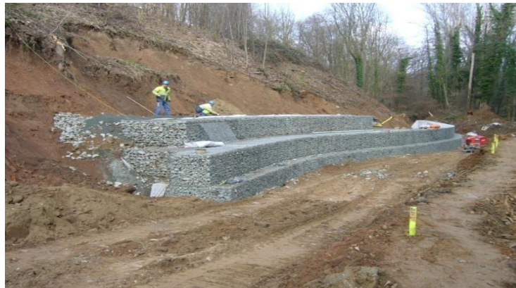
Figure 2.3. Chantier en cours de réalisation utilisant le technique gabion.
