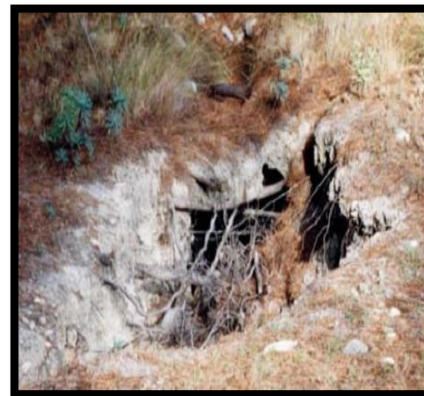
Figure1.6. Effondrement par rupture de piliers.
