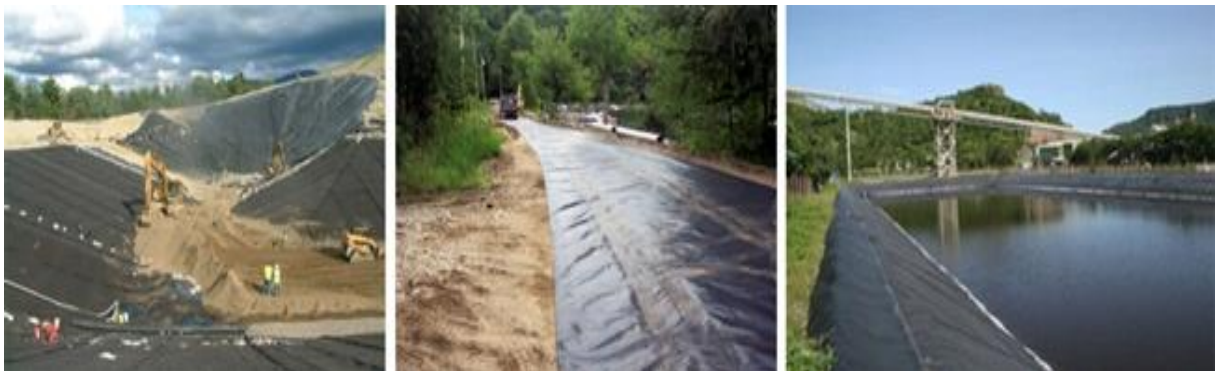
Figure 2 .19. Exemple de géomembrane.
