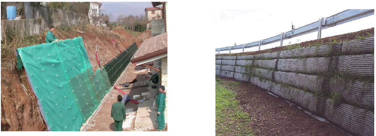
Figure 2.17. Exemple de géogrille sol.
