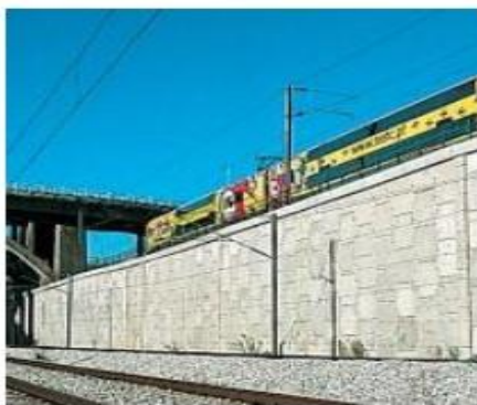
a : ouvrages ferroviaires
