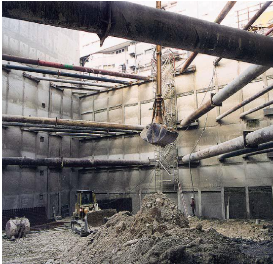
Figure 2.9. renforcement par butons
