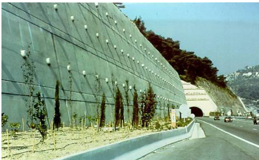
Figure 2.13. Exemple de mur cloué.
