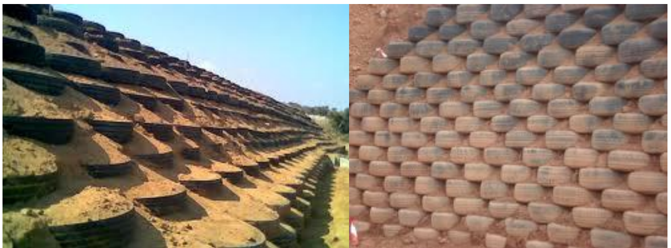
Figure .2.15. Mur en pneu sol.
