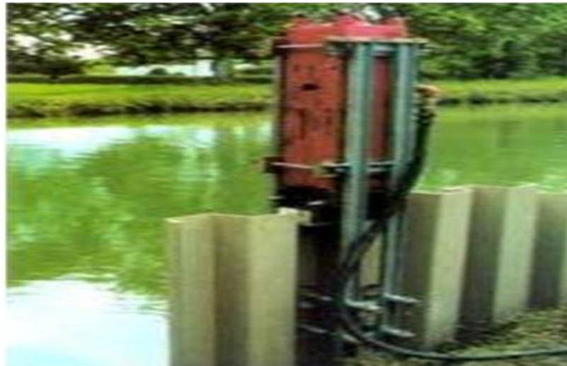
Figure 2.12. Mise en place de palplanche en PVC.
