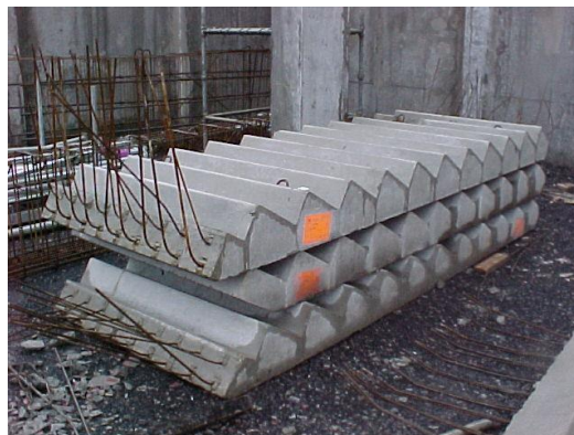
Figure III. 2: Photo d'un escalier préfabriqué en béton armé.
