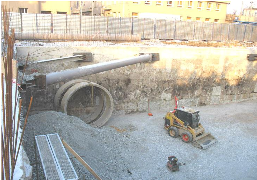
Figure 2.3. construction de paroi moulée avec butons.
