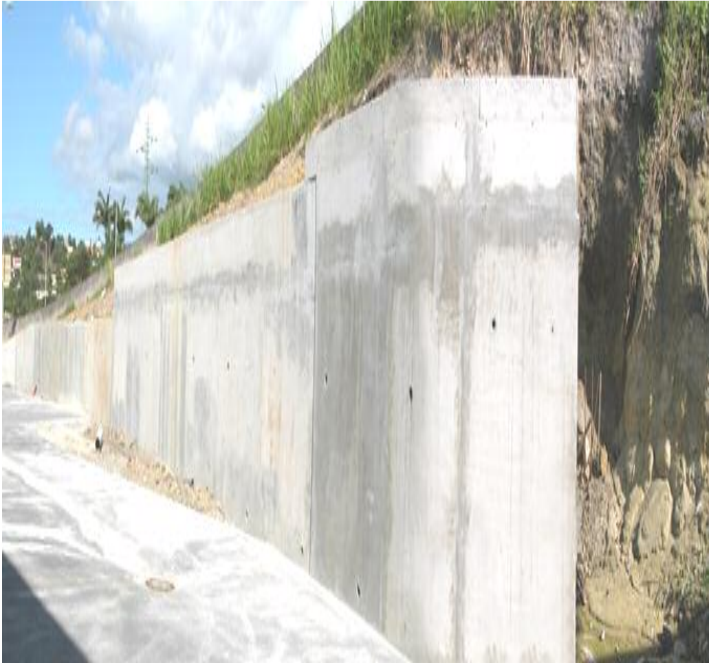
Figure 1.3. Mur de soutènement en béton
