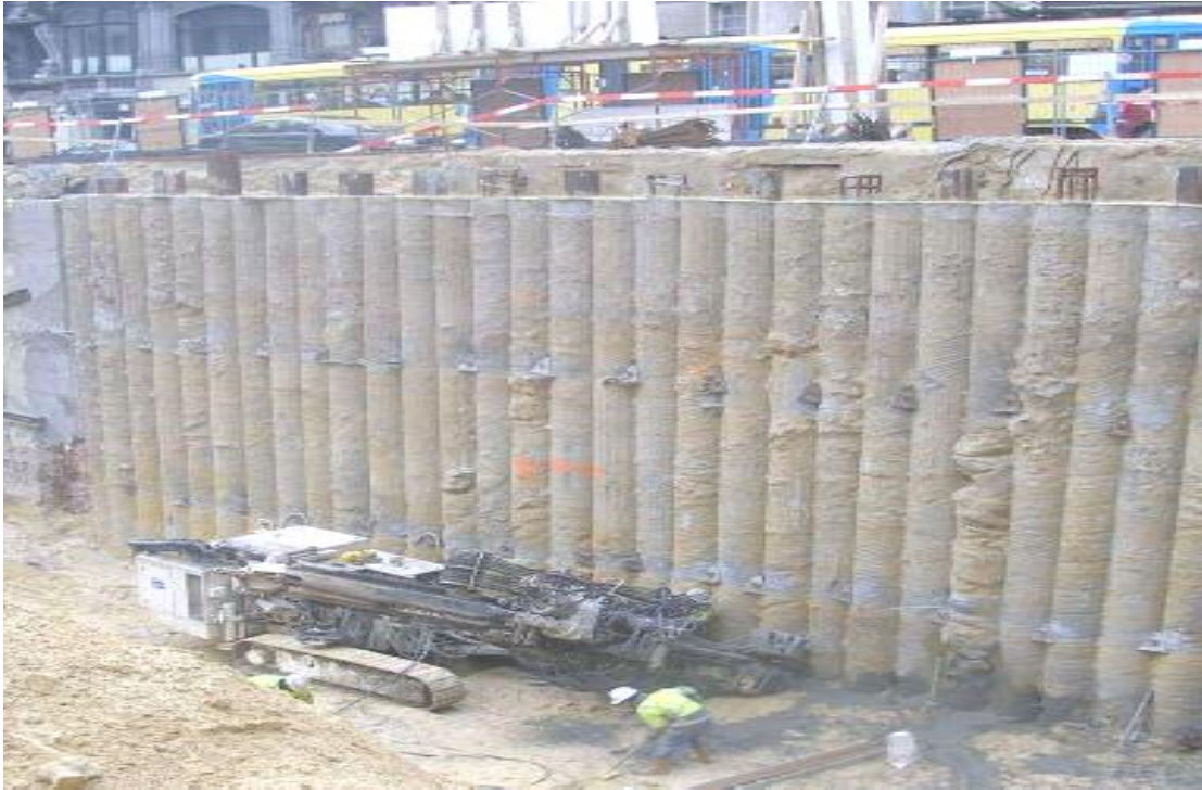
Figure 2.17. Parois en pieux
