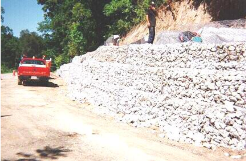
Figure 1.5. Mur en gabion
