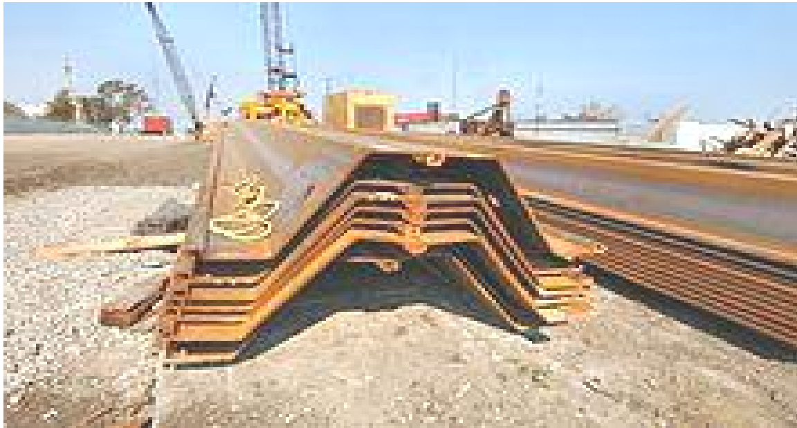
Figure 2.11. Palplanches empilées avant battage
