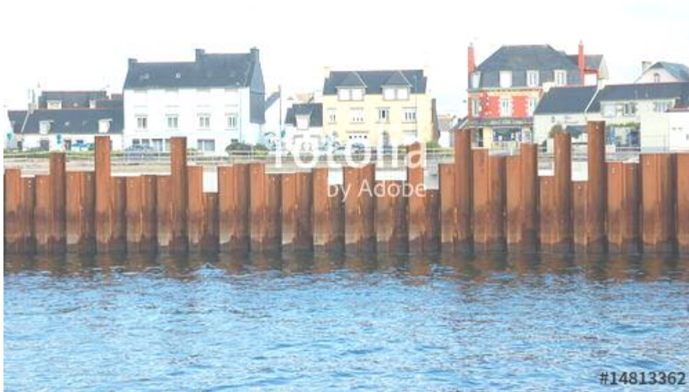
Figure 2.12. Mur en palplanche
