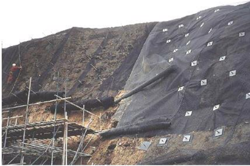
Figure 2.18. Exemple de clouage
