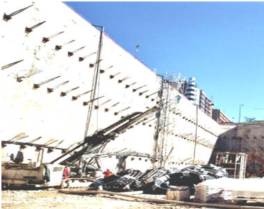
Figure 2.23. Tirant d'ancrage actif.
