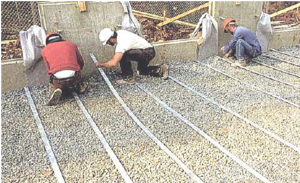
Figure 1.8. La pose d'un lit d'armatures.
