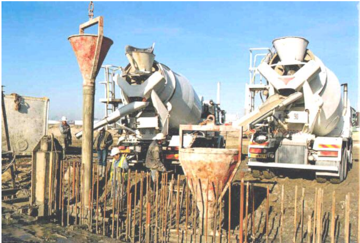
Figure 2.8. Bétonnage d'un panneau
