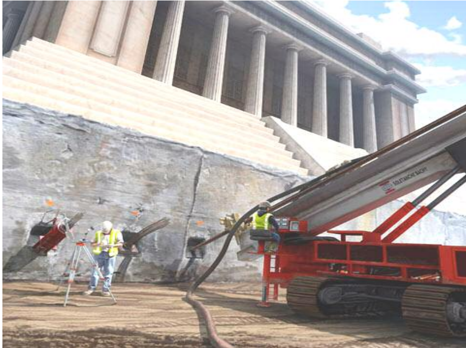
Figure 2.24. Stabilisé un ouvrage par les tirants d'ancrages
