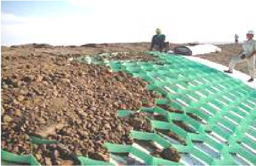
Figure 1.11. Protection géo composite drainage
