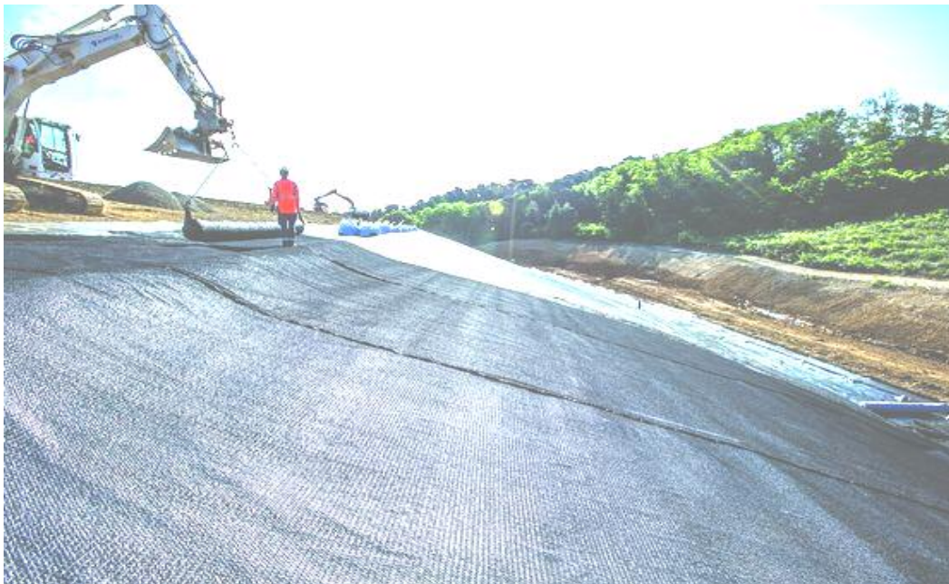
Figure 1.12. Nappes en géotextiles
