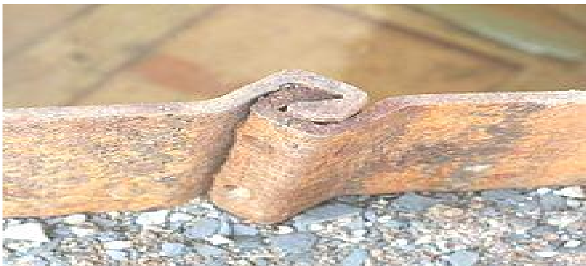
Figure 2.10. Serrure à la jonction de deux palplanches.
