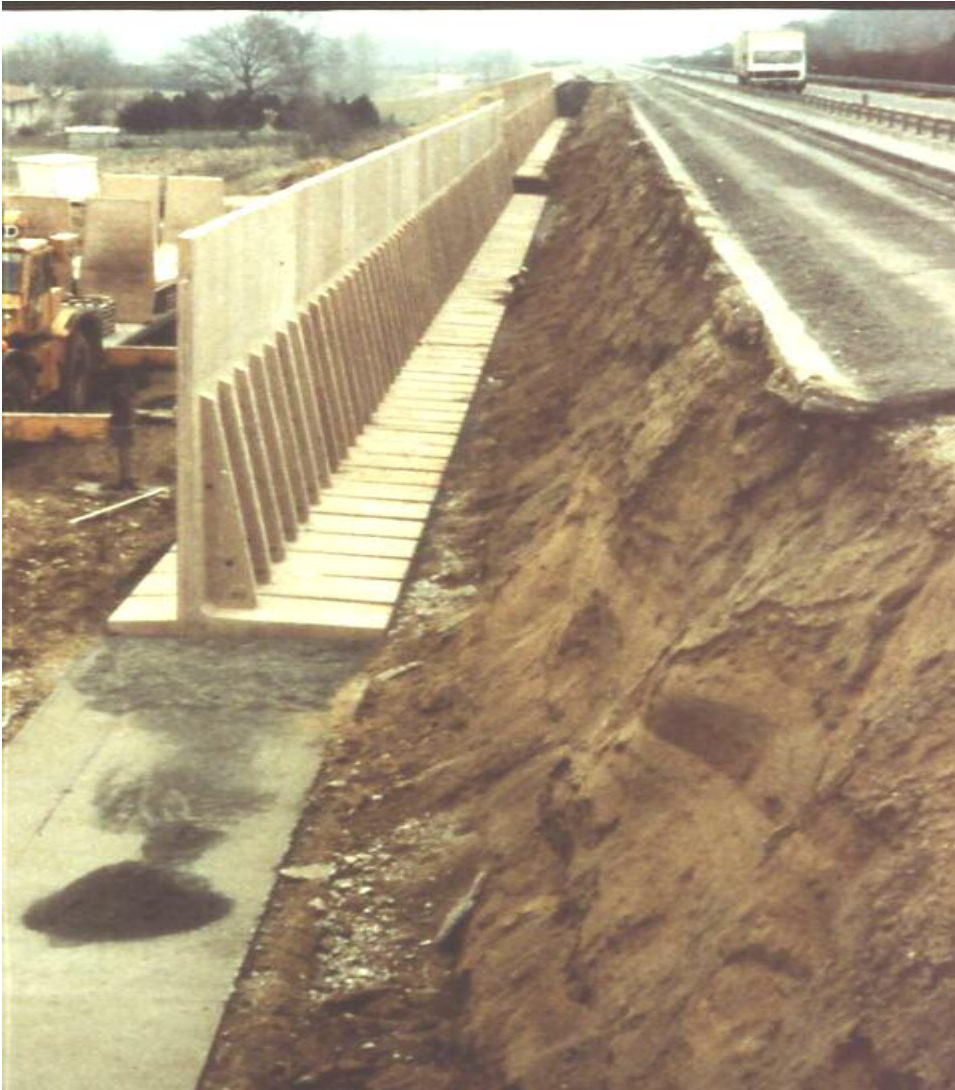
Figure 1.4. Mur en béton armé
