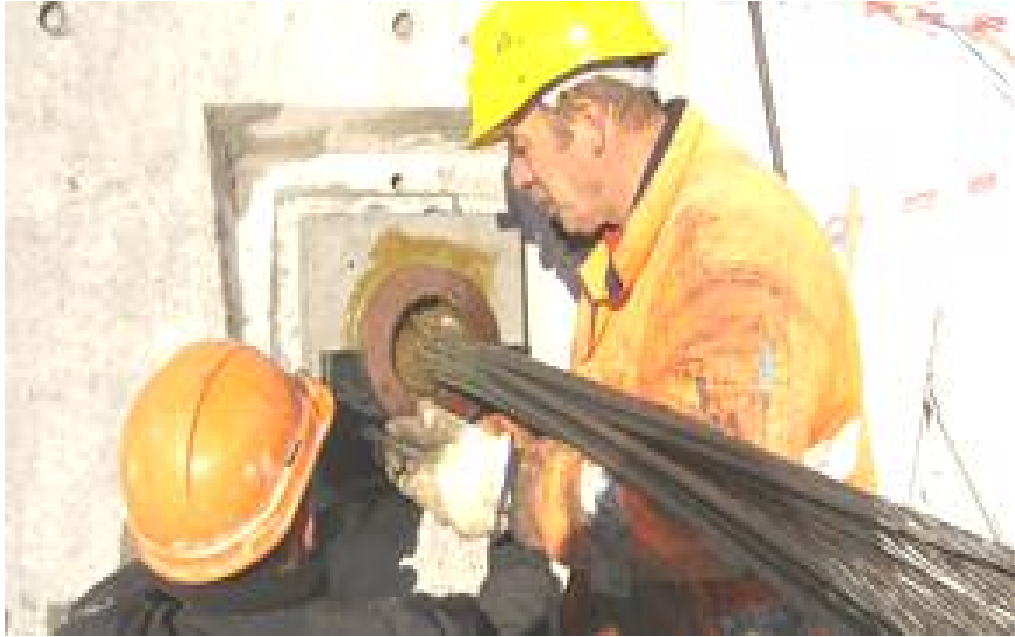
Figure 2.21. La mise en place de tirant d'ancrage
