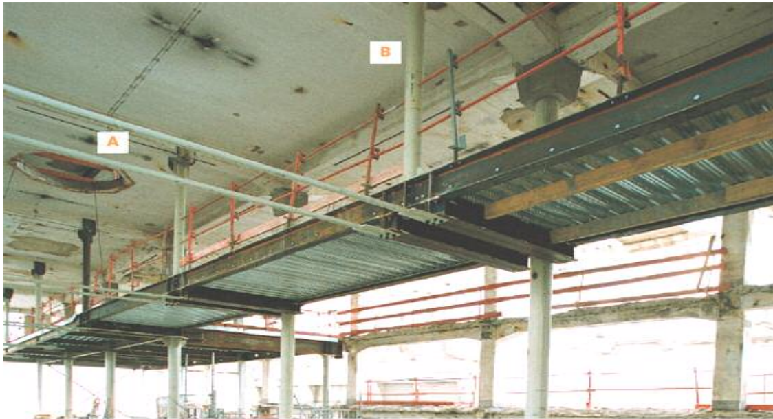
Tirants de maintien horizontaux (A) et verticaux (B) d'une coursive
