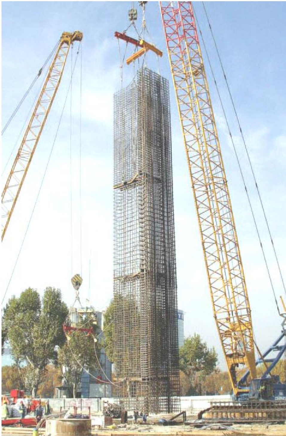
Figure 2.7. Mise en place d'une cage d'armatures.
