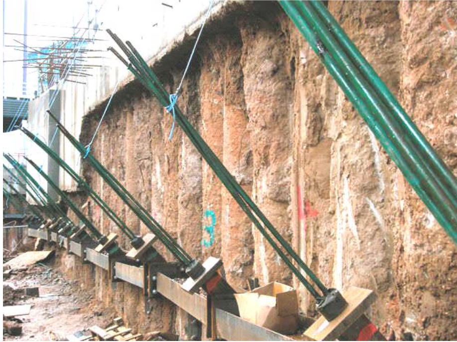
Figure 2.16. Paroi en pieux tangent
