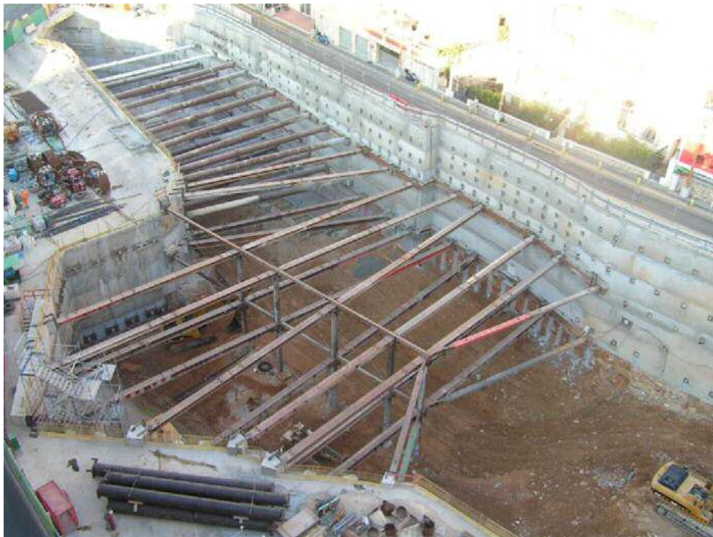
Figure 2.26. Exemple de butonnage
