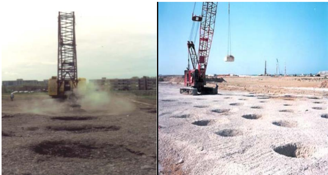
Figure 3-4 : exemples de chantiers de compactage dynamique (documents de Géopac® et Ménard et soltraitement®)
