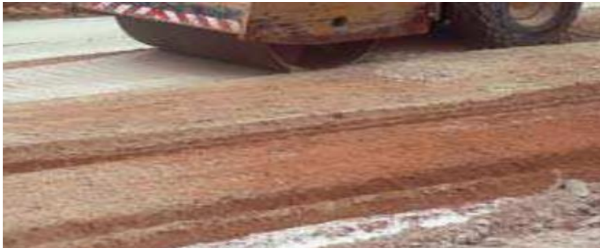
Figure 3-22 : Compactage partiel (DOCUMENTATION TECHNIQUE Routes n°89 • Septembre 2004 )
