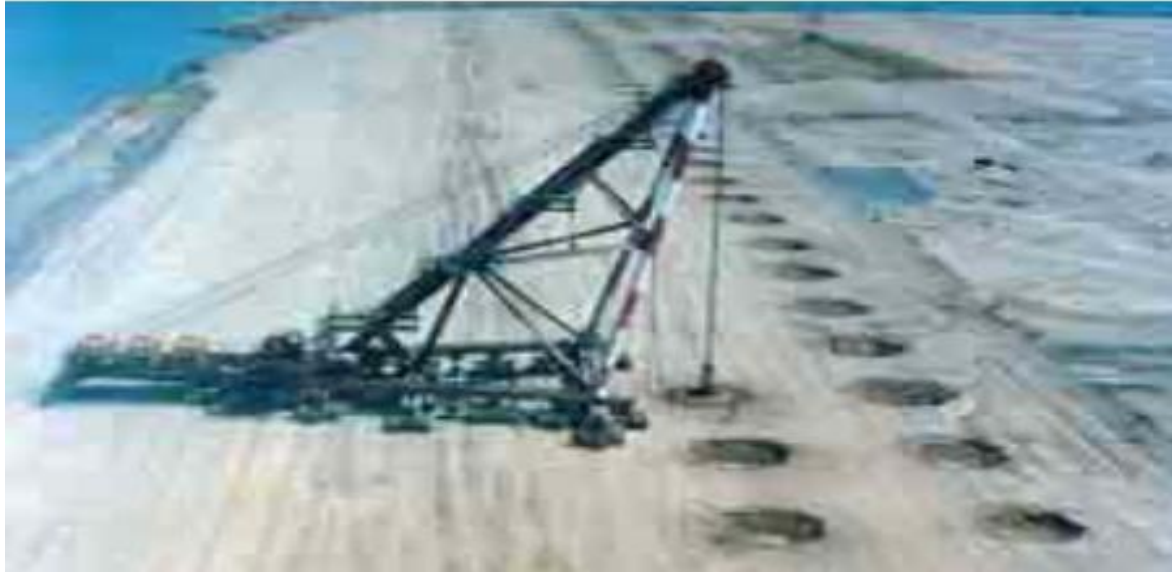
Figure 3-7 : chantier de compactage dynamique ( aéroport de Nice-France) (documents de Ménard soltraitement®)
