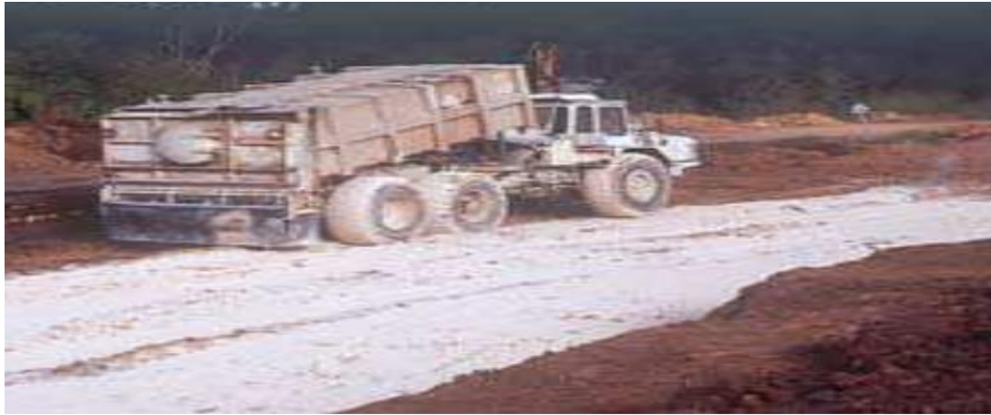
Figure 3-20 :Epannage du liant (DOCUMENTATION TECHNIQUE Routes n°89 • Septembre 2004 )
