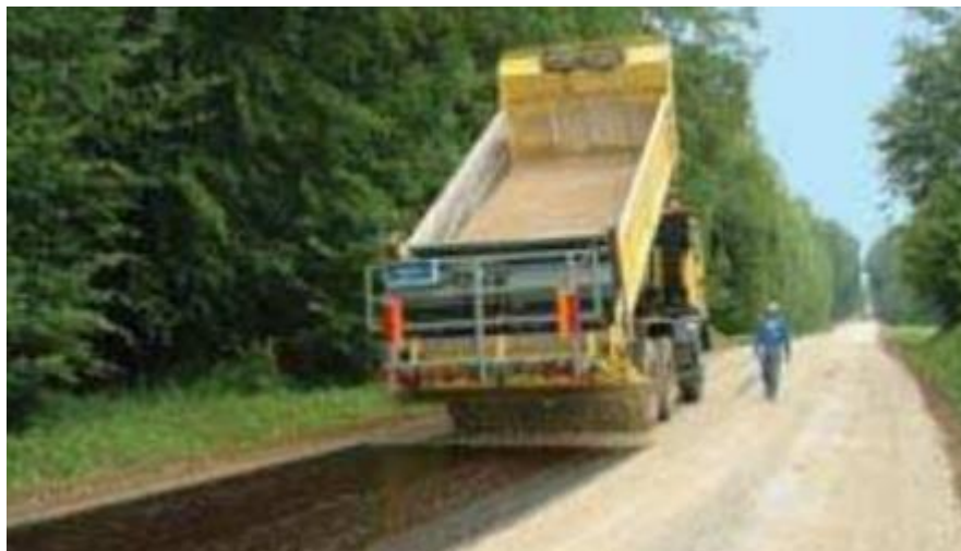
Figure3-24 :Protection de surface de la couche traitée (DOCUMENTATION TECHNIQUE Routes n°89 • Septembre 2004 )
