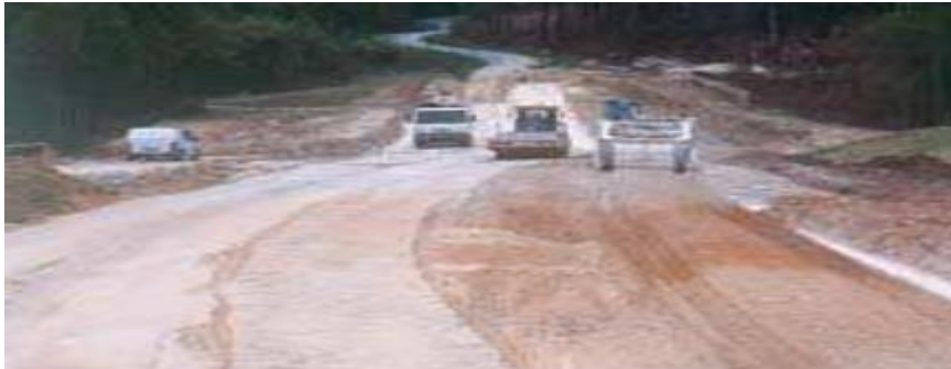
Figure3-23 :Compactage final (DOCUMENTATION TECHNIQUE Routes n°89 • Septembre 2004 )
