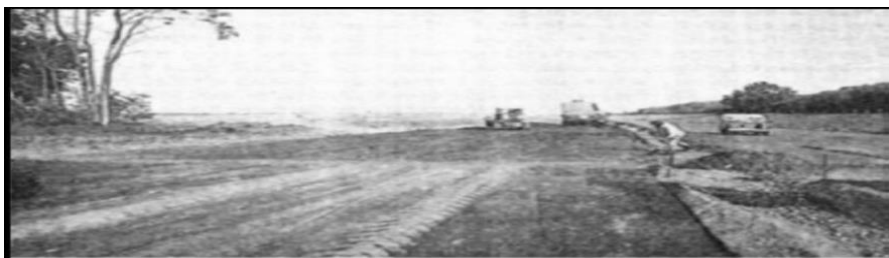
Figure 3-25 : Chantier de traitement du sol au ciment [Bell,1978].
