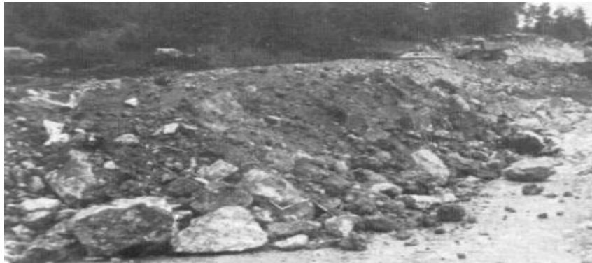
Figure 1-7 : Exécution d'un remblai routier sur la RN9.
