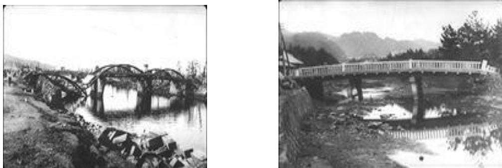
Figure II.8. Le séisme de Kanto (Japon) de 1923. Grands tassements et rotations au niveau de la fondation de piles de ponts.
