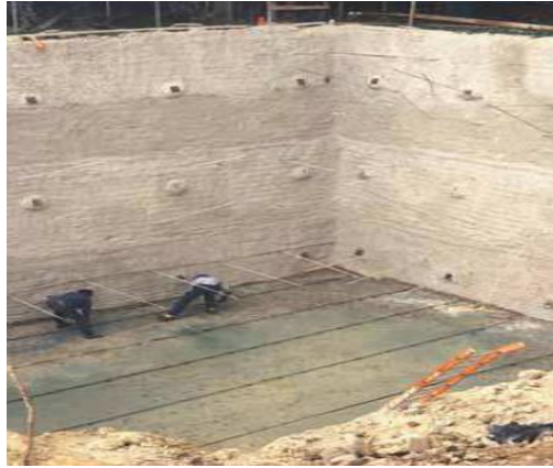
Figure 1.3 - Ouvrage neuf, paroi clouée en soutènement d'excavation
