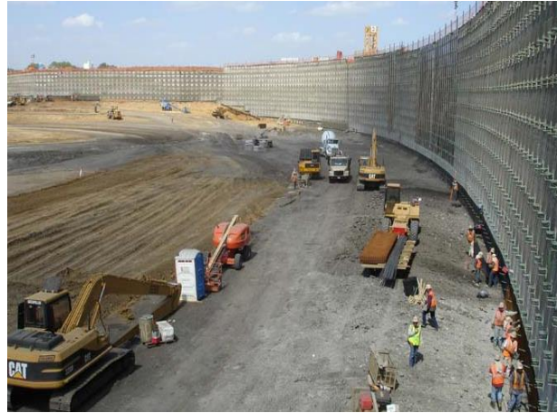
Figure I.1 - Mur cloué réalisé en courbe
