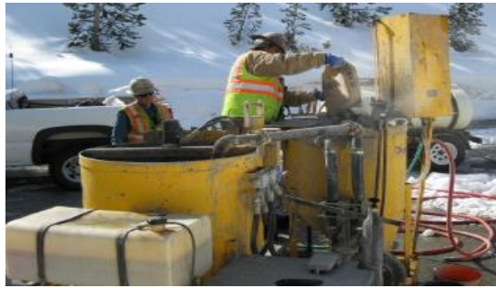
Figure I.17 - Pompe d'injection et malaxeur de coulis de ciment
