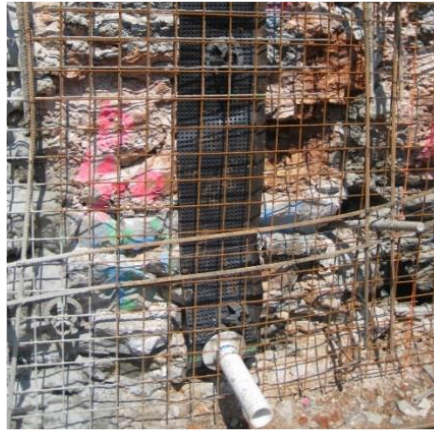
Figure I.10 - L'installation de la bande de drainage avant la première mise en place du béton projeté
