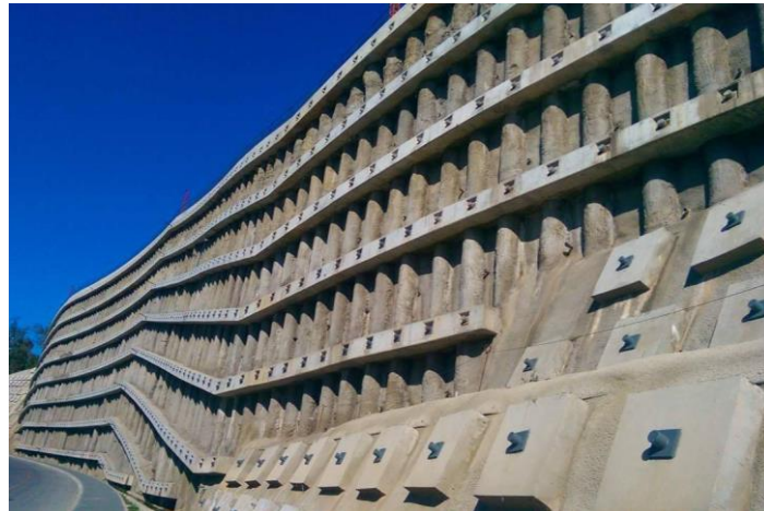
Figure II.24 - Stabilisation des pentes par tirants d'ancrage et pieux, Constantine.
