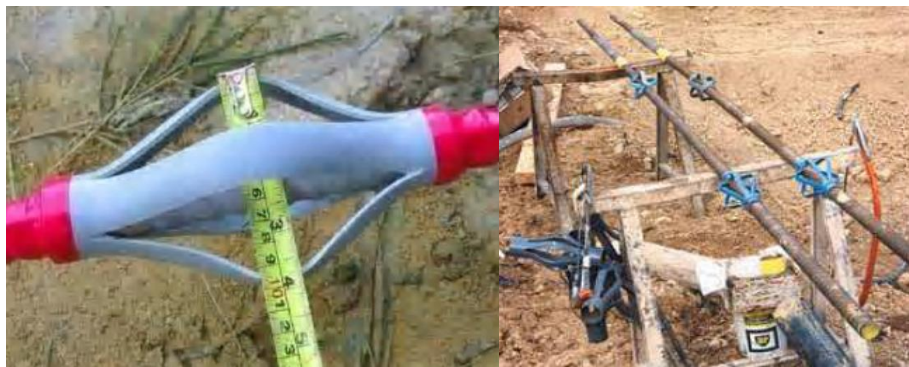
Figure I.16 - Centralisateurs fixés sur les barres de renforcement
