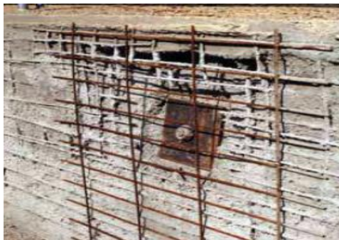
Figure I.23 - Détail d'une tête de clou, cas des barres en acier à haute adhérence pour béton armé
