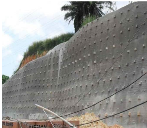
Figure 1.24 - Enrobage des extrémités des têtes clous par le béton du parement
