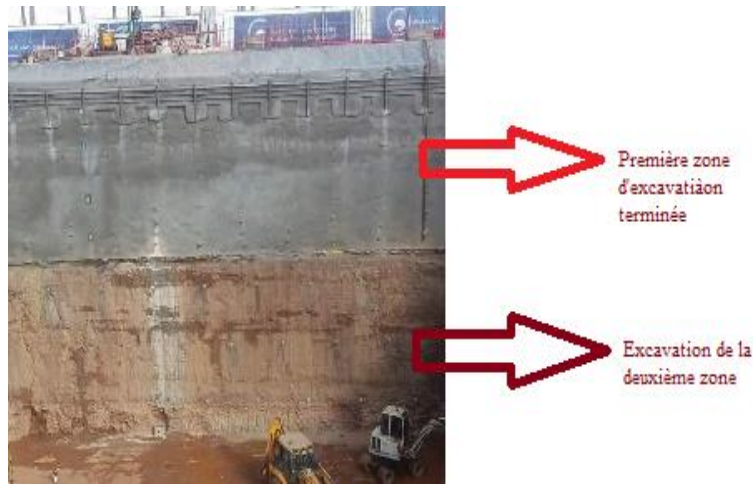
Figure I.12 - Technique d'excavation par niveau ; niveau 1 terminé, niveau 2 commencé
