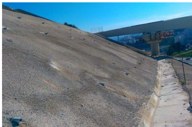
Figure II.23 - Stabilisation par correction de la pente et installation du système de drainage, Constantine.
