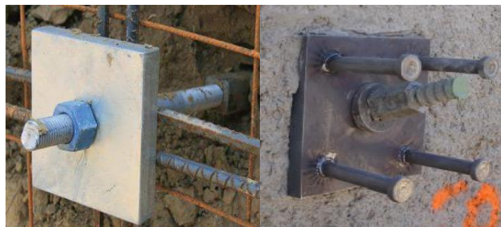
Figure I.18 - Détails sur la tête des clous
