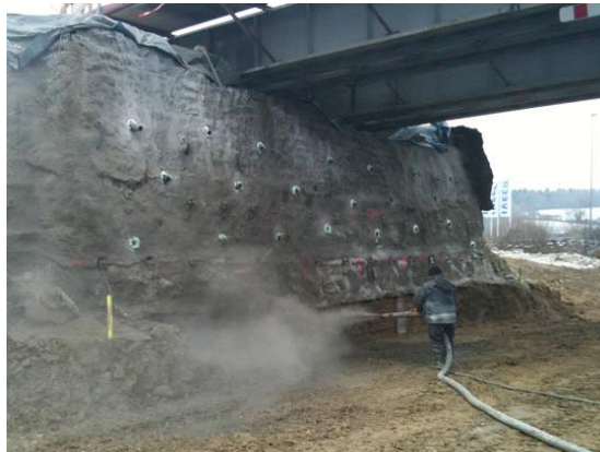
Figure 1.4 - Elargissement d'une route sous un tablier d'ouvrage d'art
