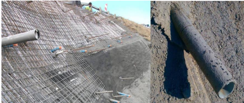
Figure I.27 - Barbacanes placées à plusieurs niveaux
