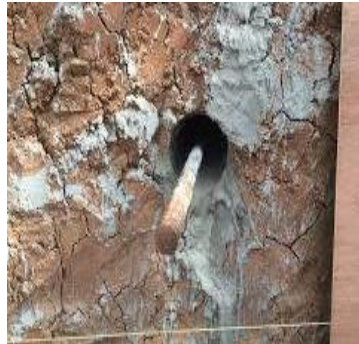
Figure I.8 - Mise en place d'une barre d'acier après forage
