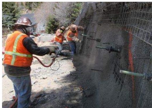
Figure I.11 - Mise en place de béton projeté in-situ
