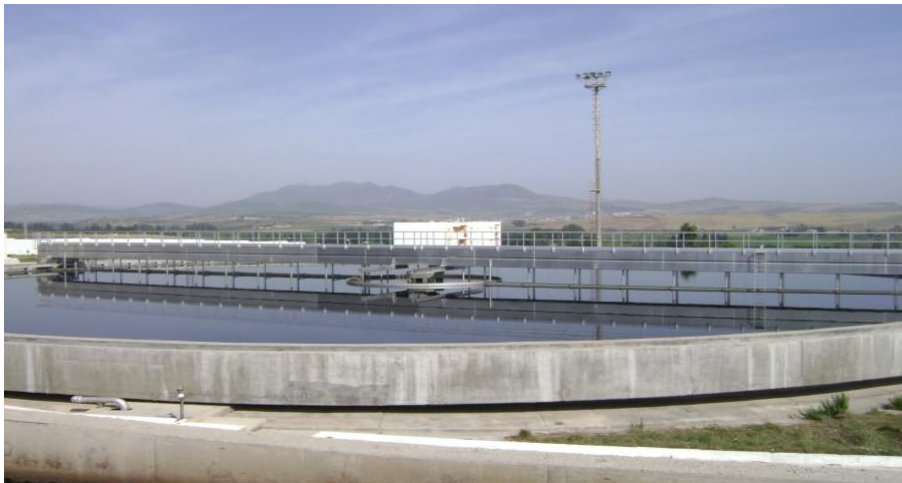
Photo (3-1) : Décanteur secondaire « clarificateur »
