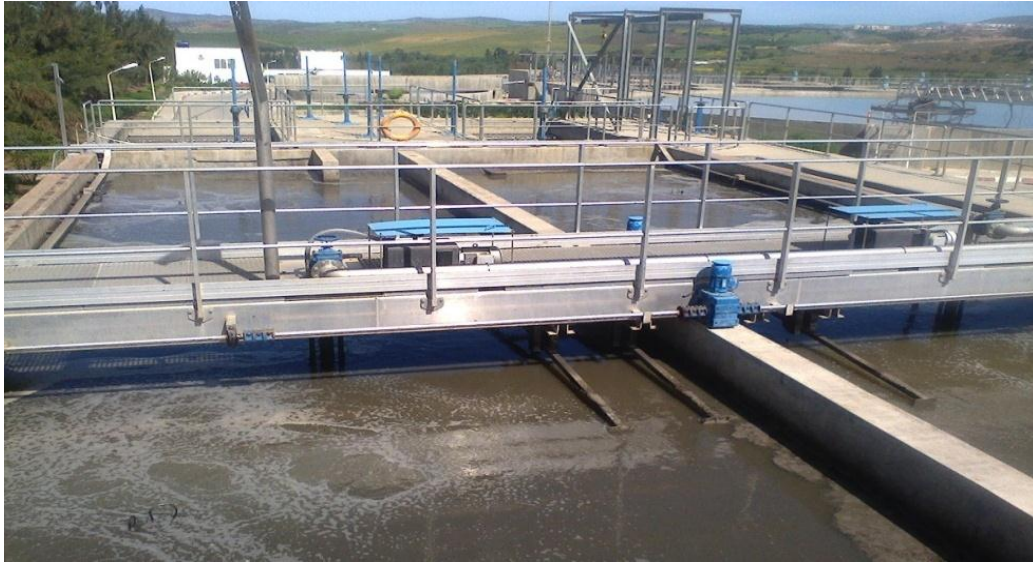
Photo (1-3) : Bassins de dessablage, déshuilage et dégraissage (STEP Guelma, 2015).
