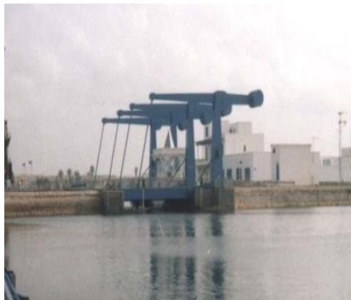
Figure I. 12: Deux ponts levis à Sfax, Tunisie, construit en 1998.
