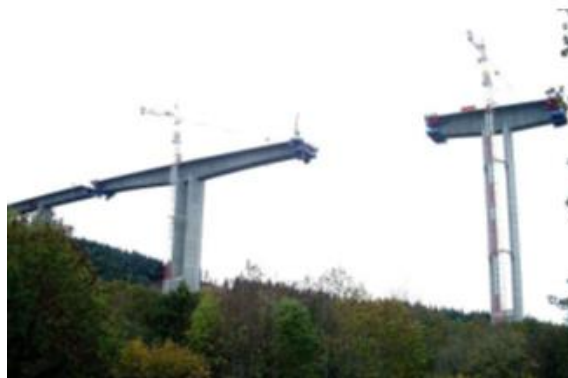
Figure I. 2 : Viaduc construit par encorbellement successif.
