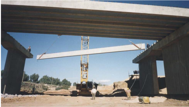
Figure I. 3 : Mise en place d'une poutre préfabriquée.
