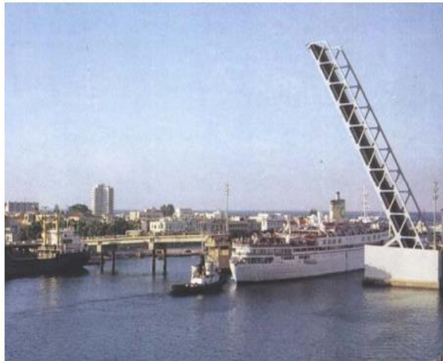
Figure I. 11: Pont Basculant de Bizerte, Tunisie, construit en 1980
