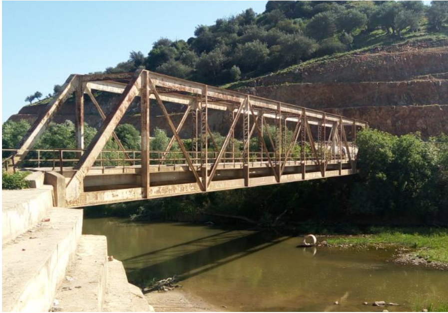
Figure IV. 2: Ancien pont métallique.
