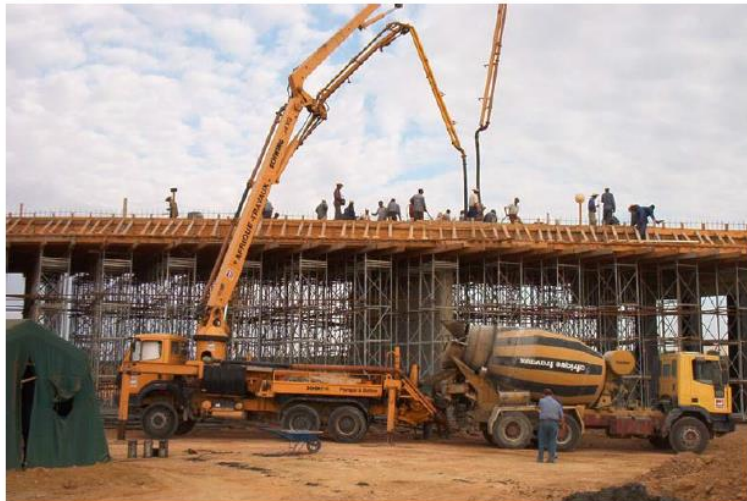
Figure I. 1 : Pont dalle coulé sur échafaudage au sol.
