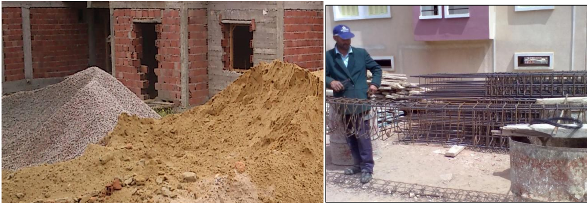
Photo 16. Gravier 5/15 et sable de mer
