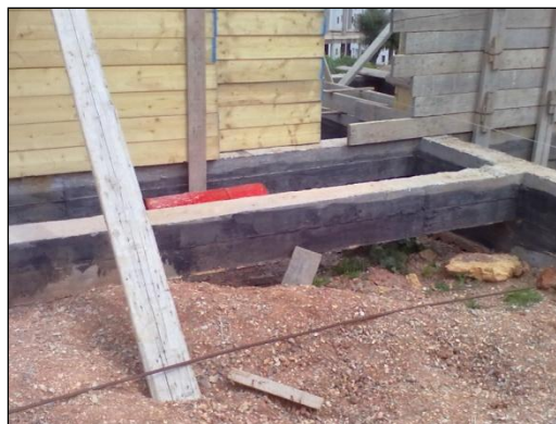
Photo 20. Longrines et zone de dalle flottante
