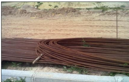
Photo 31. Aciers pour éléments de structure
