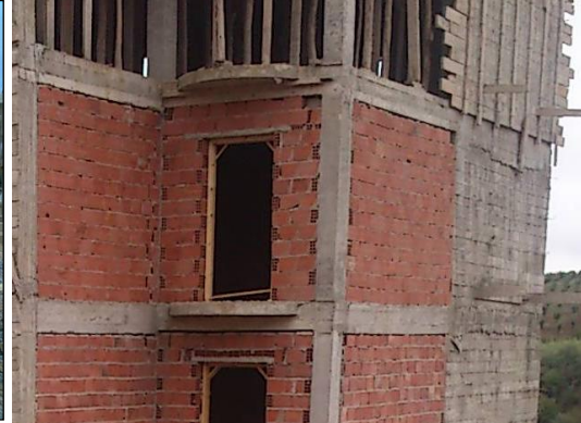
Photo 22. les voiles de contreventement
