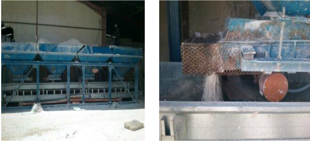
Photo III.6: les 4 silos et le tapis de passage.
