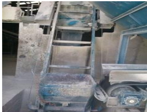
Photo III.7: skip de bétonnage.
