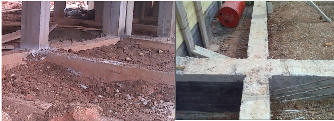
Photo 18. Zone de Dalle flottante
