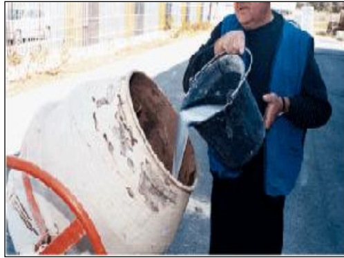
Photo 30. L'eau de gâchage.
