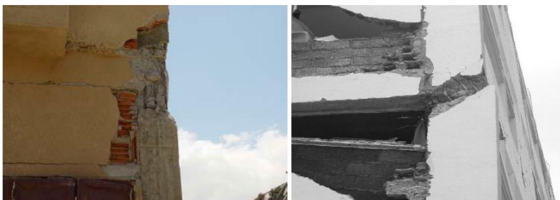
Figure I.11. Eclatement de la zone nodale due à la poussé diagonale de la maçonnerie
