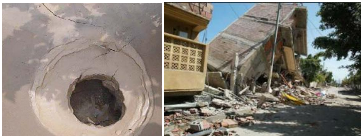
Figure I.23. Le phénomène de liquéfaction séisme de Boumèrdes2003
