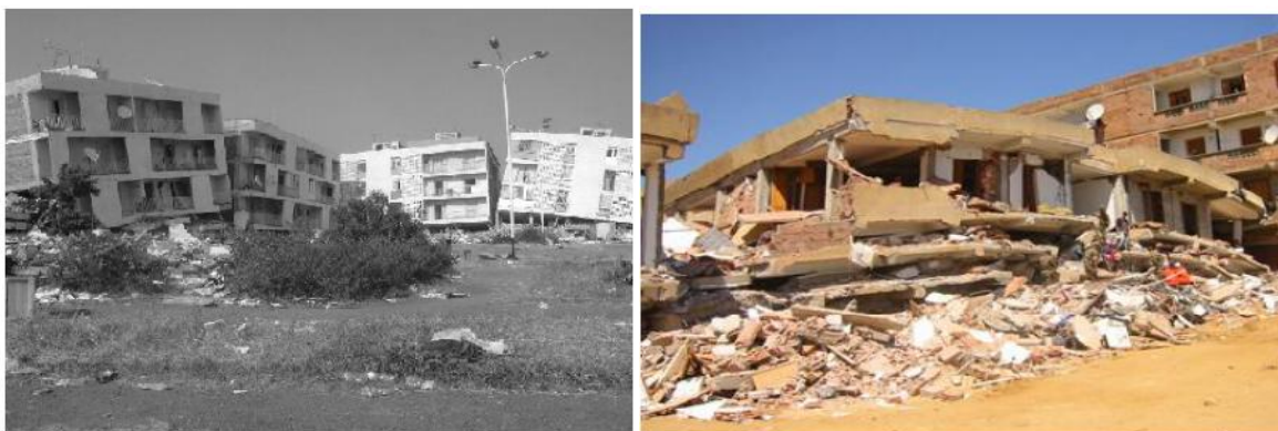
Figure I.10. Effondrement de bâtiments auto-stables avec remplissages en maçonnerie due à des déplacements important
